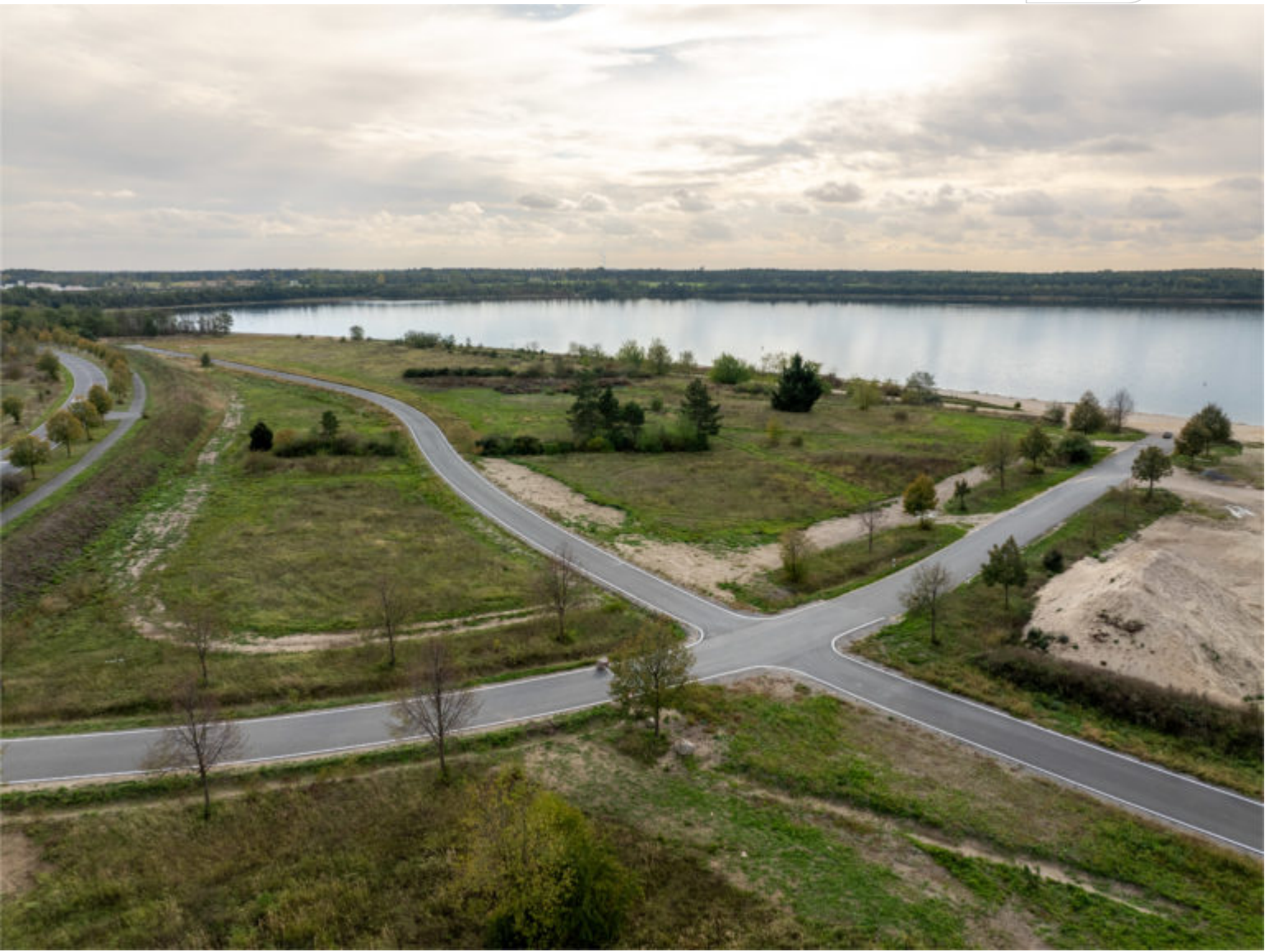
Neuer asphaltierter Uferwegeabschnitt
