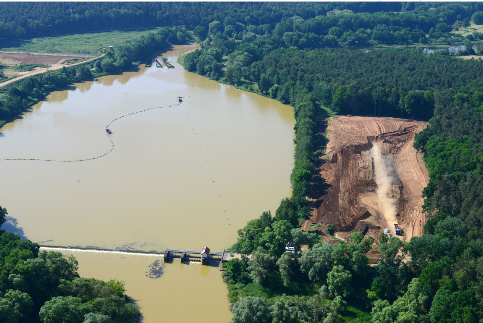
Sedimentationsbecken an der Vorsperre Bühlow
