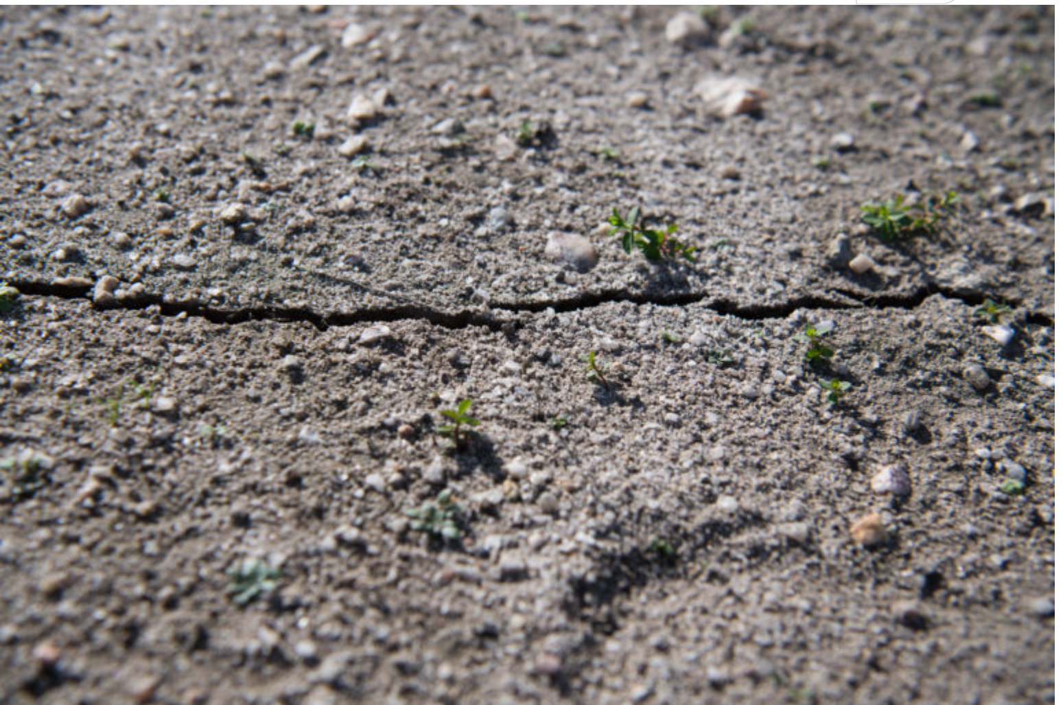
Ein durch die Erdsprengung entstandener Riss.
