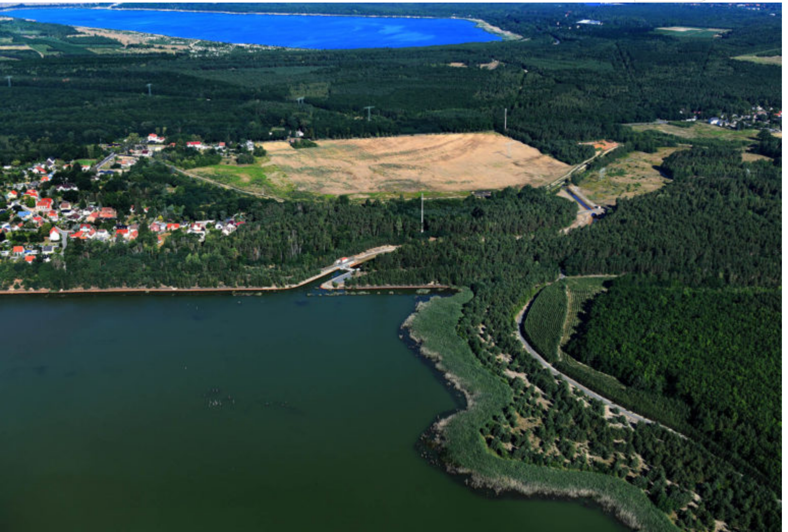
Auslaufbauwerk aus dem SB Burghammer
