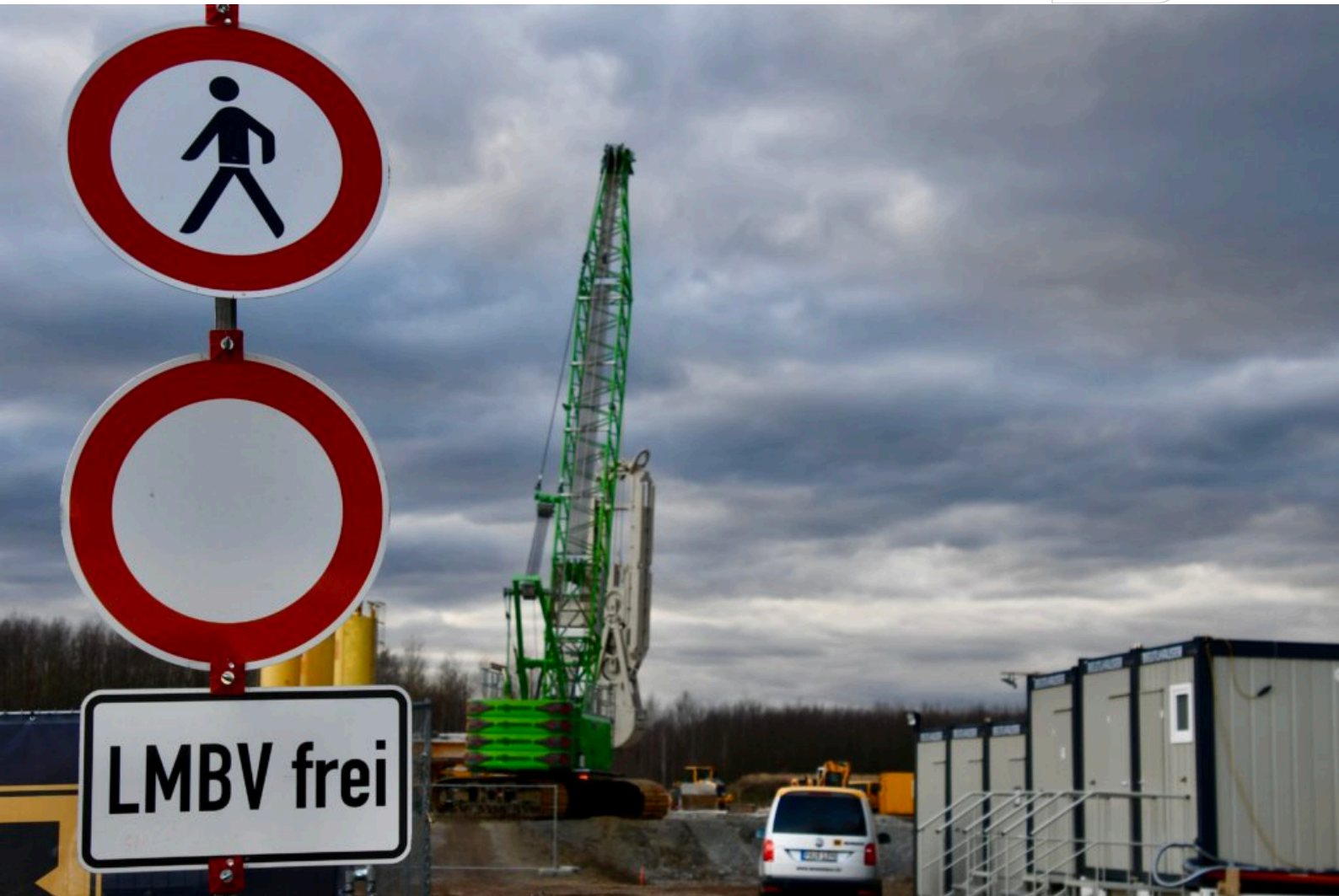
Schlitzwandbaustelle am Zwenkauer See
