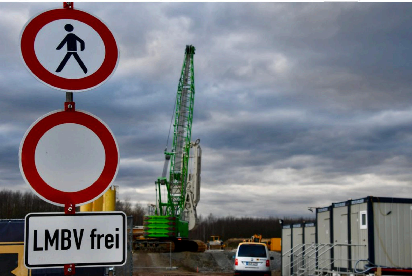
Schlitzwandbaustelle am Zwenkauer See
