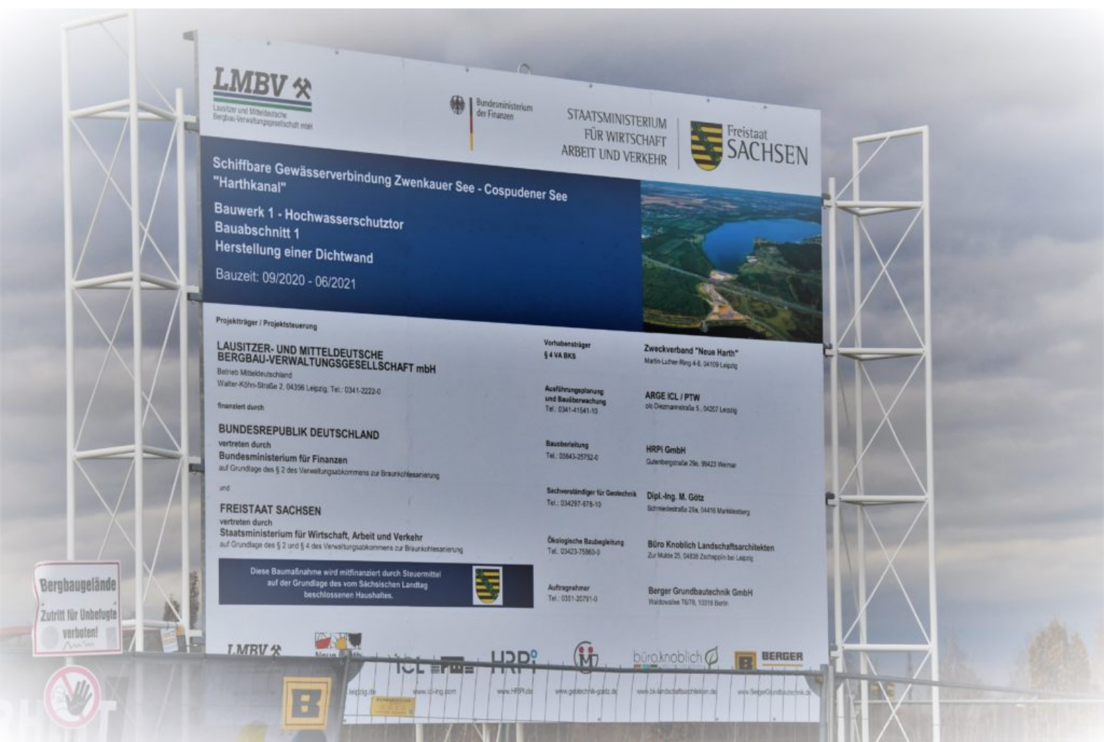
LMBV-Baustellenschild für Dichtwandbau per Schlitzfen Leipzig. Derzeit laufen die nach vorzeitigem Baubeginn genehmigten Arbeiten der LMBV für den Einbau einer Dichtwand zwischen dem
