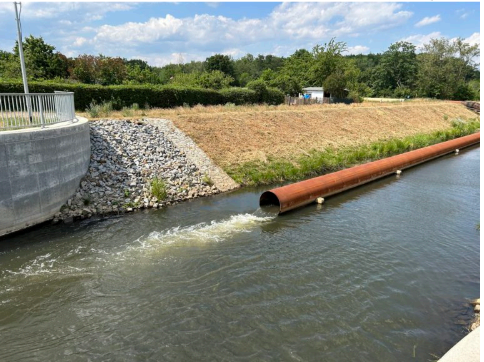
500 l/s Stützungswasser für die Schwarze Elster kommen derzeit von der LMBV.
