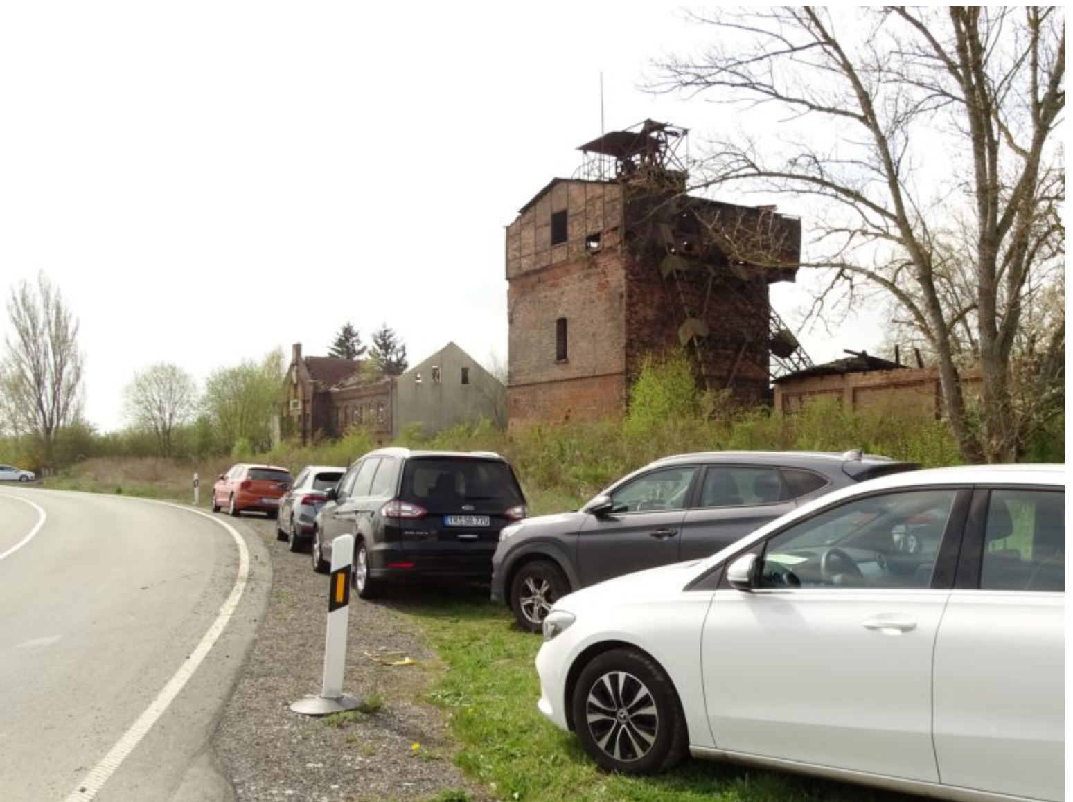
Blick zur Schachthanlage, die im Zuständigkeitsbereich der LMBV liegt.
