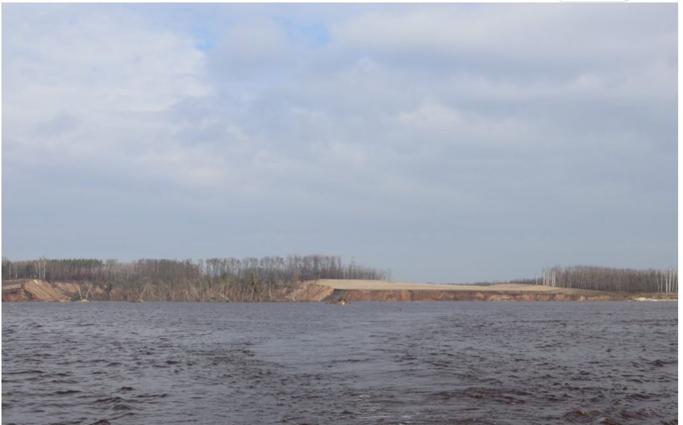
Archivaufnahme der Sanierung
