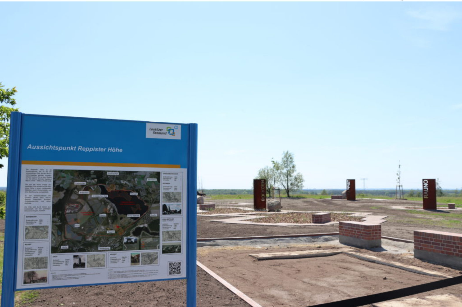
Erneuerter Aussichtspunkt Reppister Höhe fast fertig gestellt
