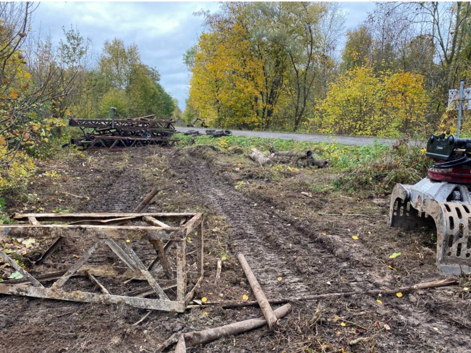
Reste der technischen Anlagen
