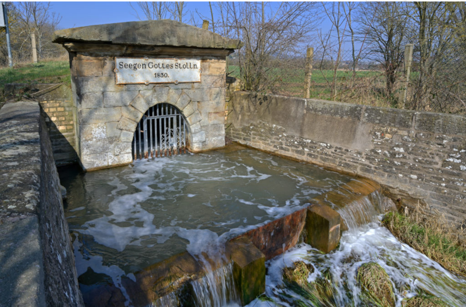
Mundloch des Segen-Gottes-Stollen vom Schaubergwerk Röhrigschacht in Wettelrode nach Sangerhausen, als Zufluss in die Gonna. Foto am 24. März 2022. Archivfotos der LMBV aus dem März 2022
