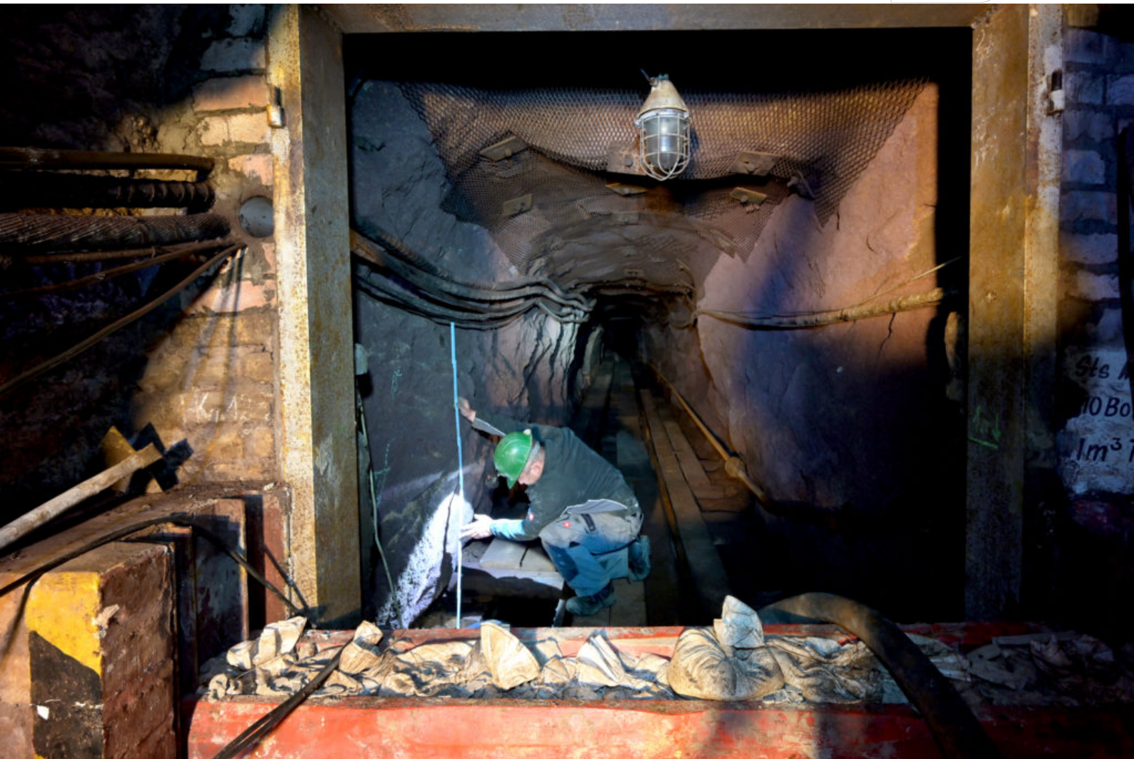
Pegelmessung im Areal des temporären Damms
