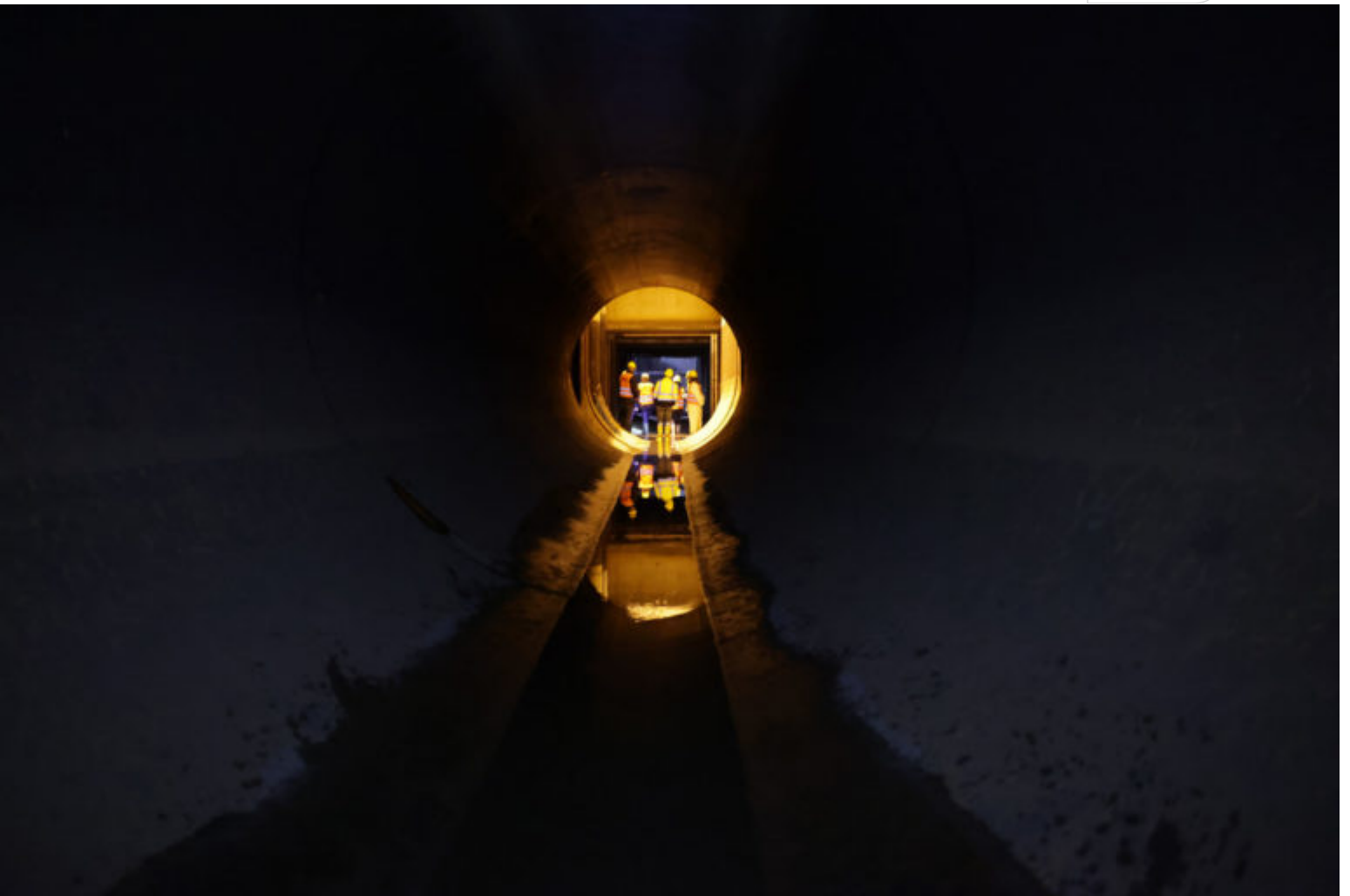
LMBV Überleiter Speicherbecken Lohsa II
