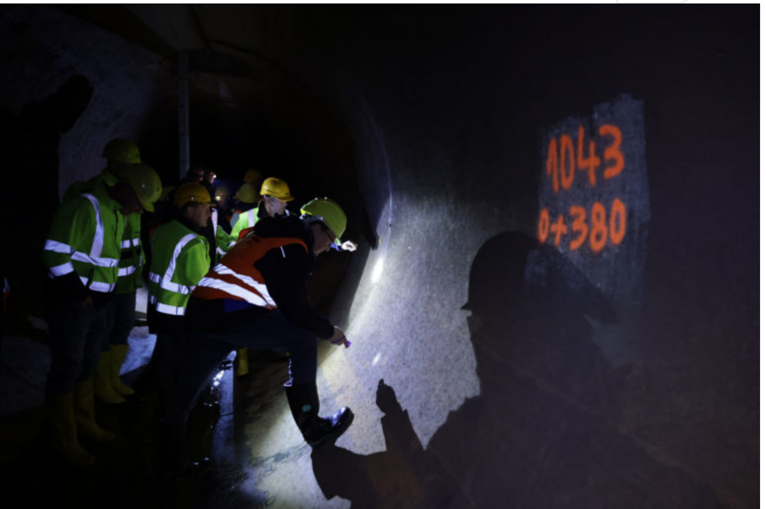
LMBV Überleiter Speicherbecken Lohsa II
