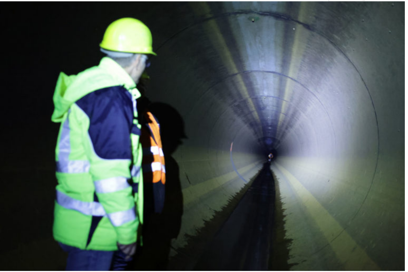
LMBV Überleiter Speicherbecken Lohsa II
