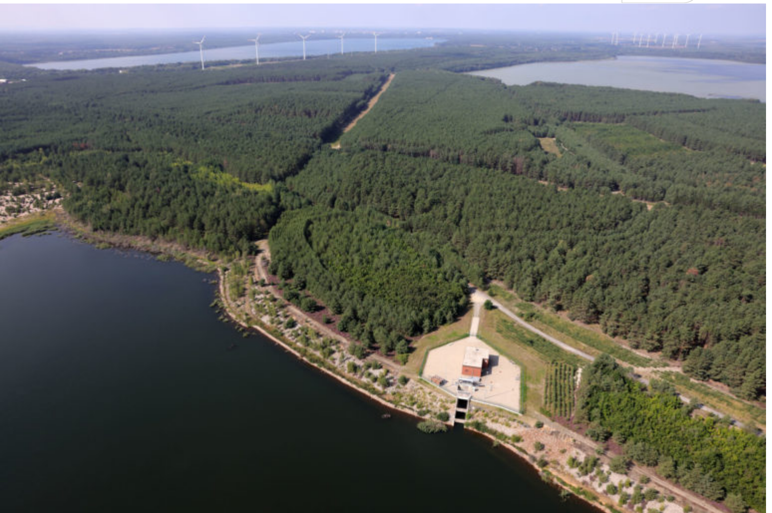
Einlaufbauwerk im SB Lohsa II
