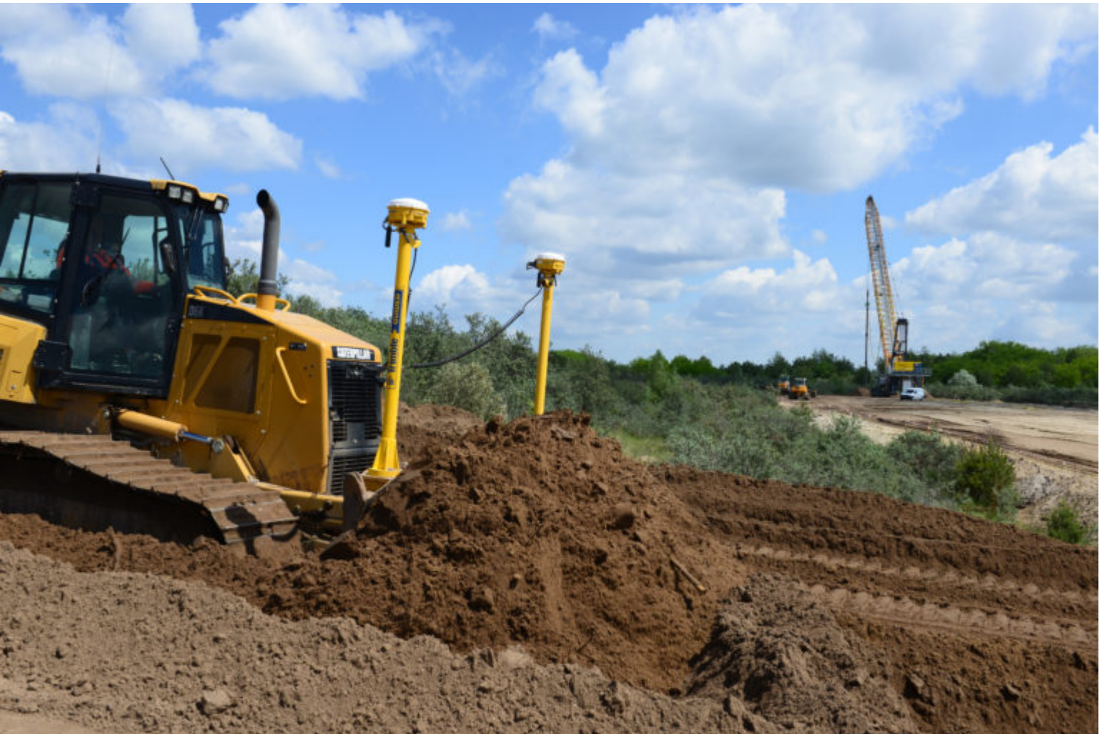
Planierarbeiten am Böschungssystem
