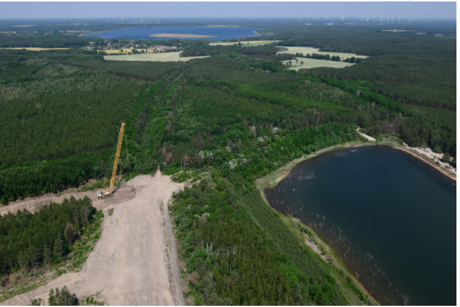
Rütteldruckverdichtung Kippe 10
