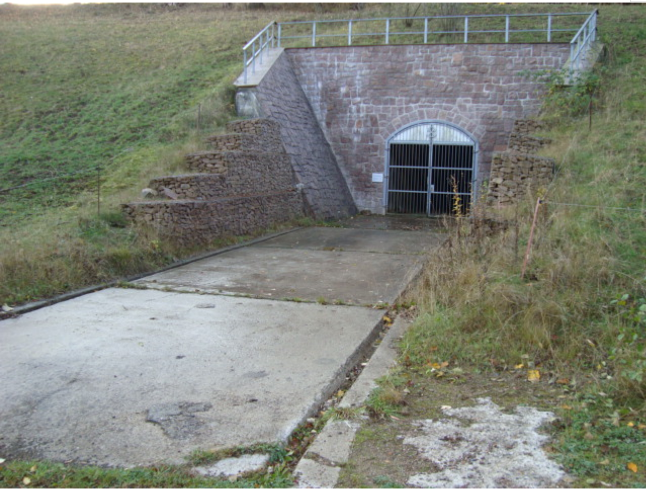
Mundloch Entwässerungsstollen Altenberg
