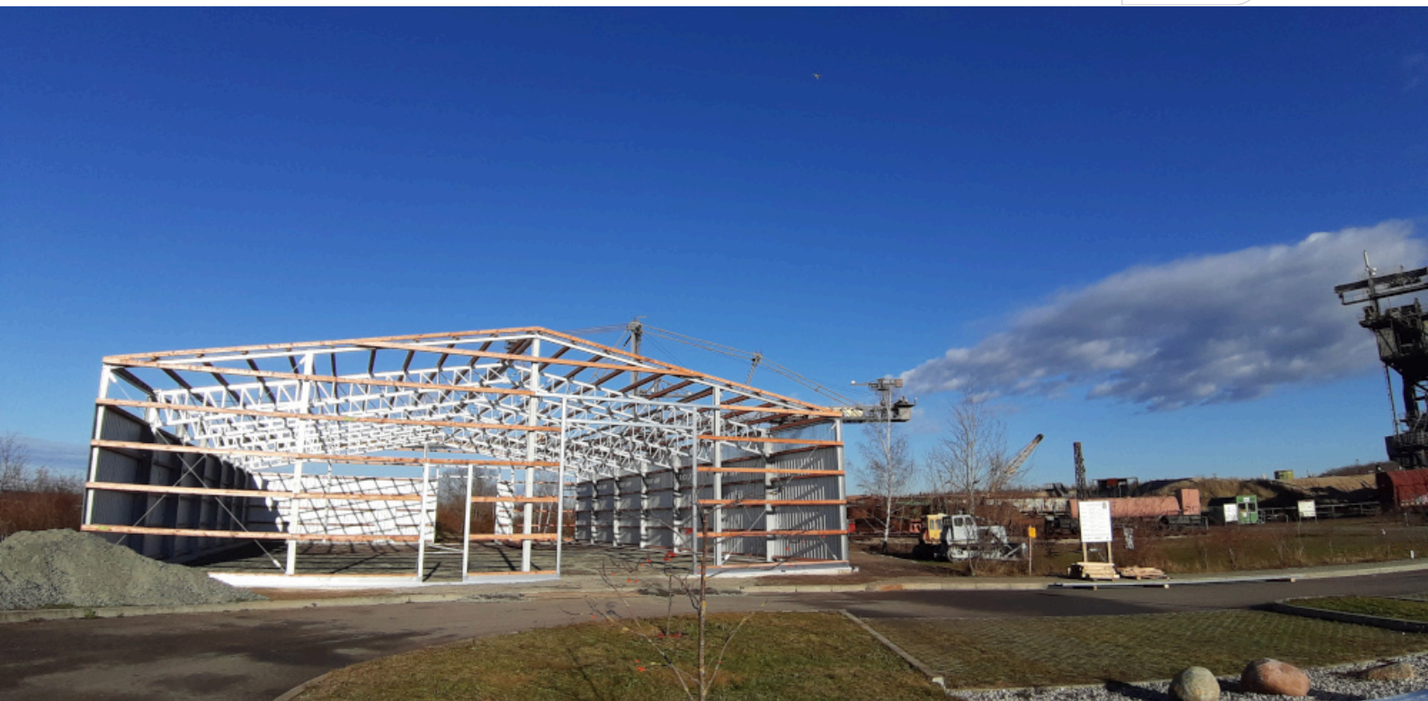
Gesamtansicht der Halle (Foto: Bergbau-Technik-Park e. V.) Eindruck vom Aufbau
