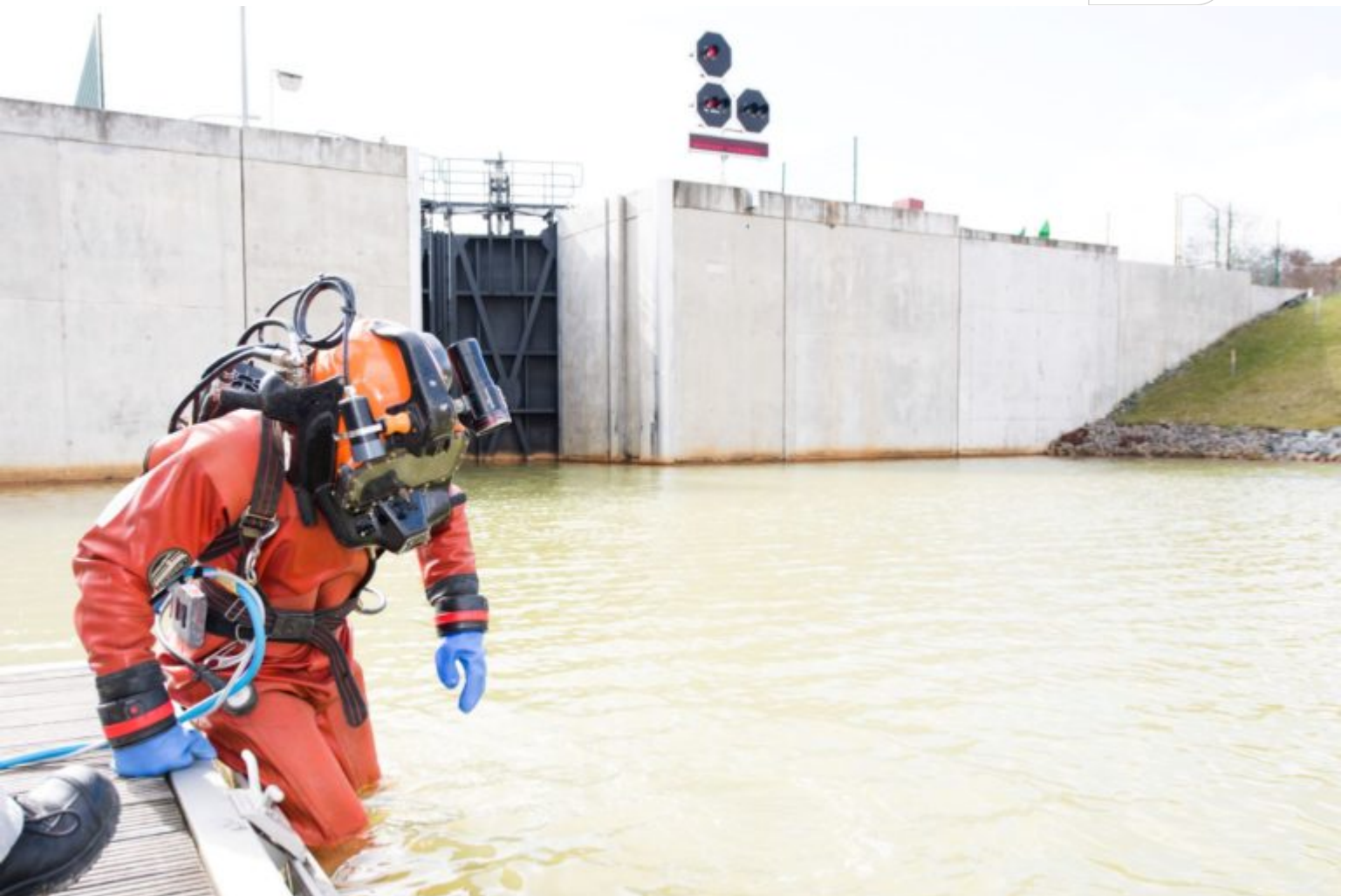
Kontrolltauchgang am unteren Schleusenvorhof am 07.04.2021
