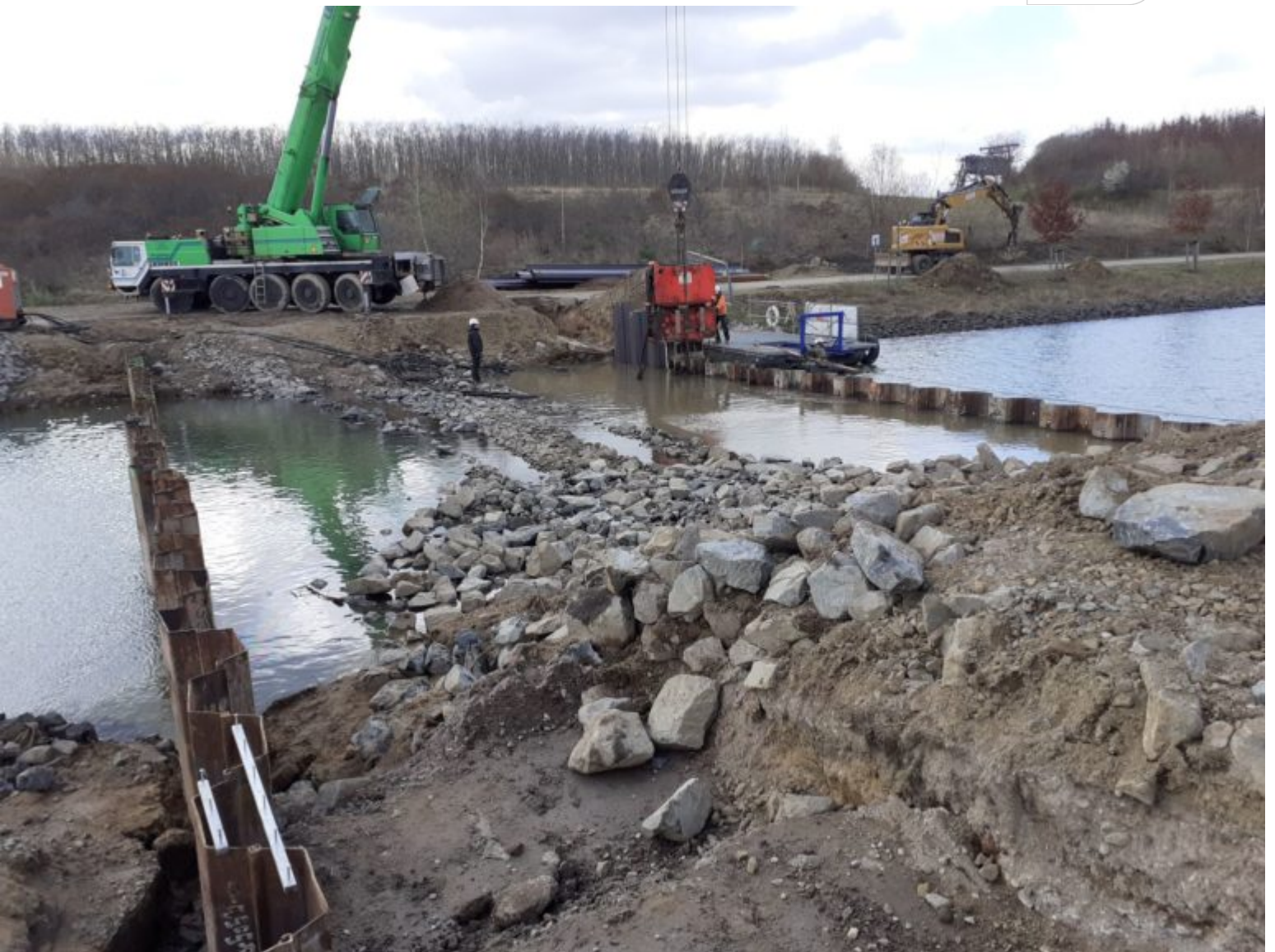
Schrittweises Auffüllen zwischen den Spundwänden
