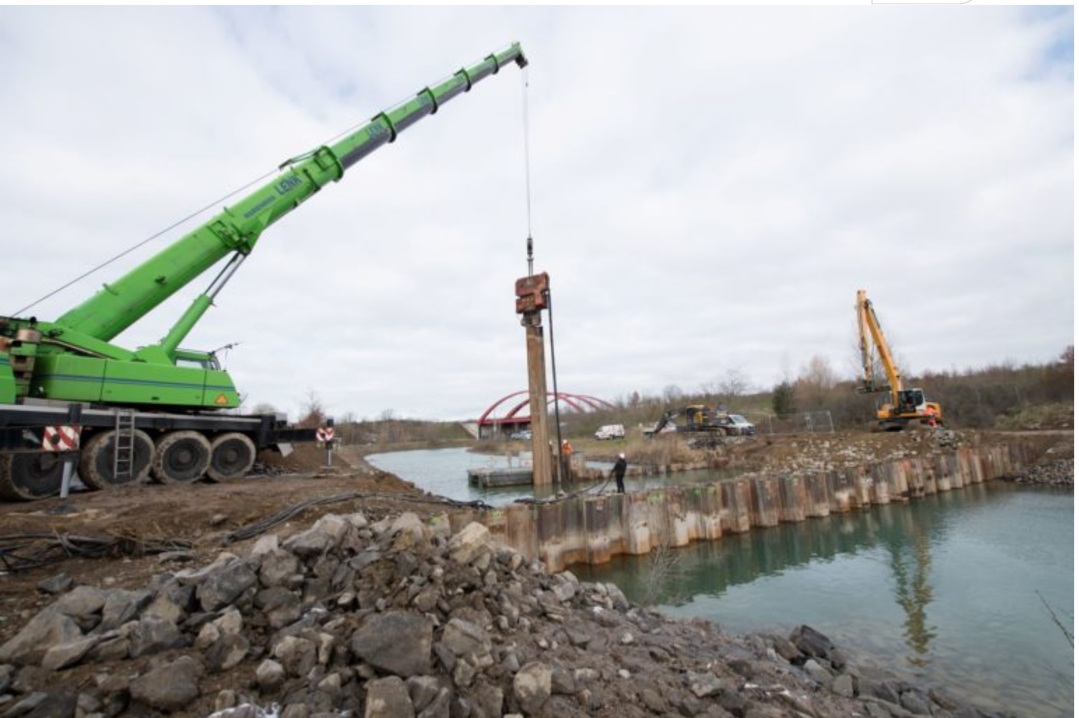
Oberer Spundwandriegel am Störmthaler Kanal im Entstehen
