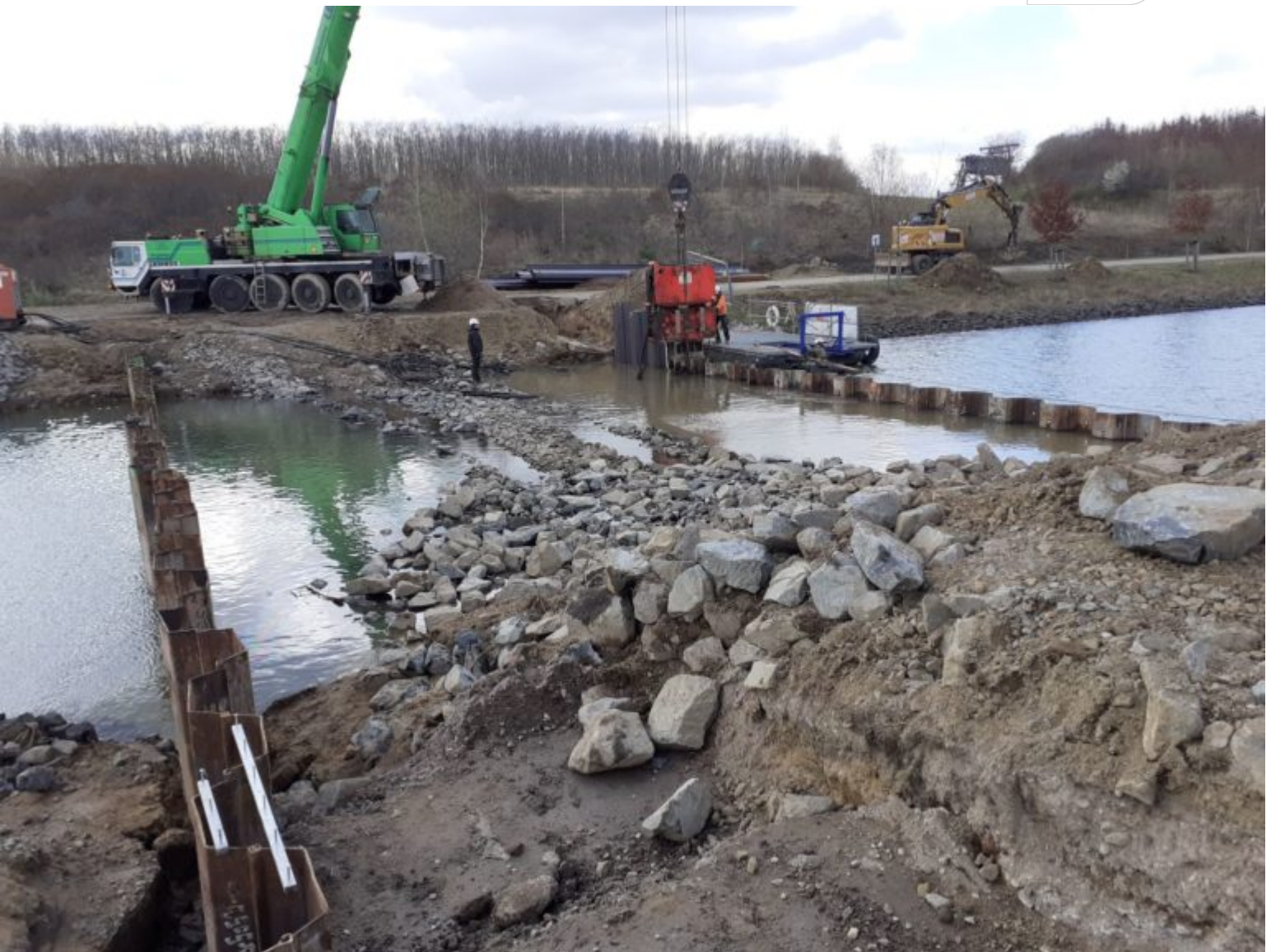
Schrittweises Auffüllen zwischen den Spundwänden
