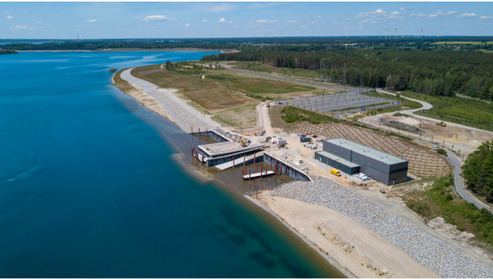
Sanierungsstützpunkt am Sedlitzer See
