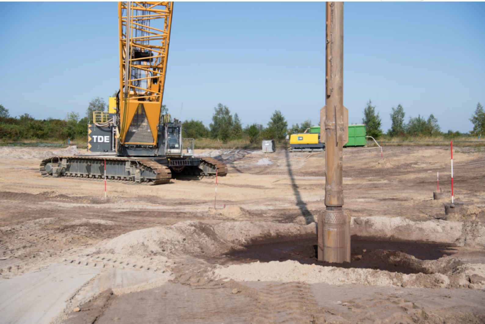
Rütteldruckverdichtung am Speicherbecken Borna
