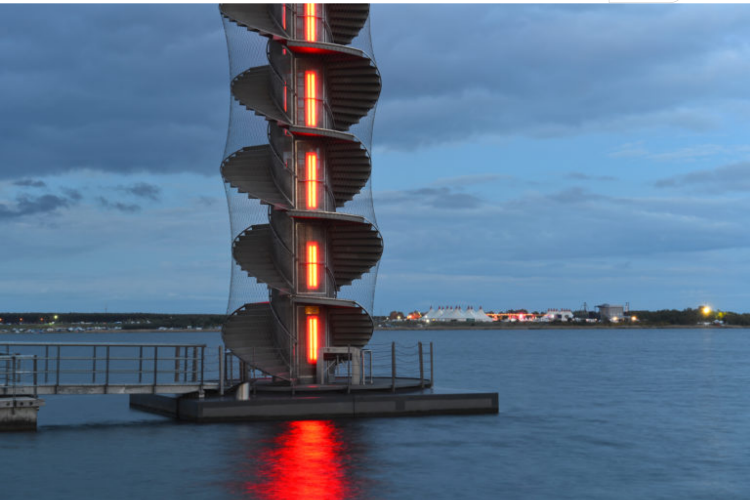
Neue Lichtinstallation in Betrieb am Pegelturm Goitzsche im Sanierungsbereich Mitteldeutschland der LMBV. Foto am 15. Mai 2016.
