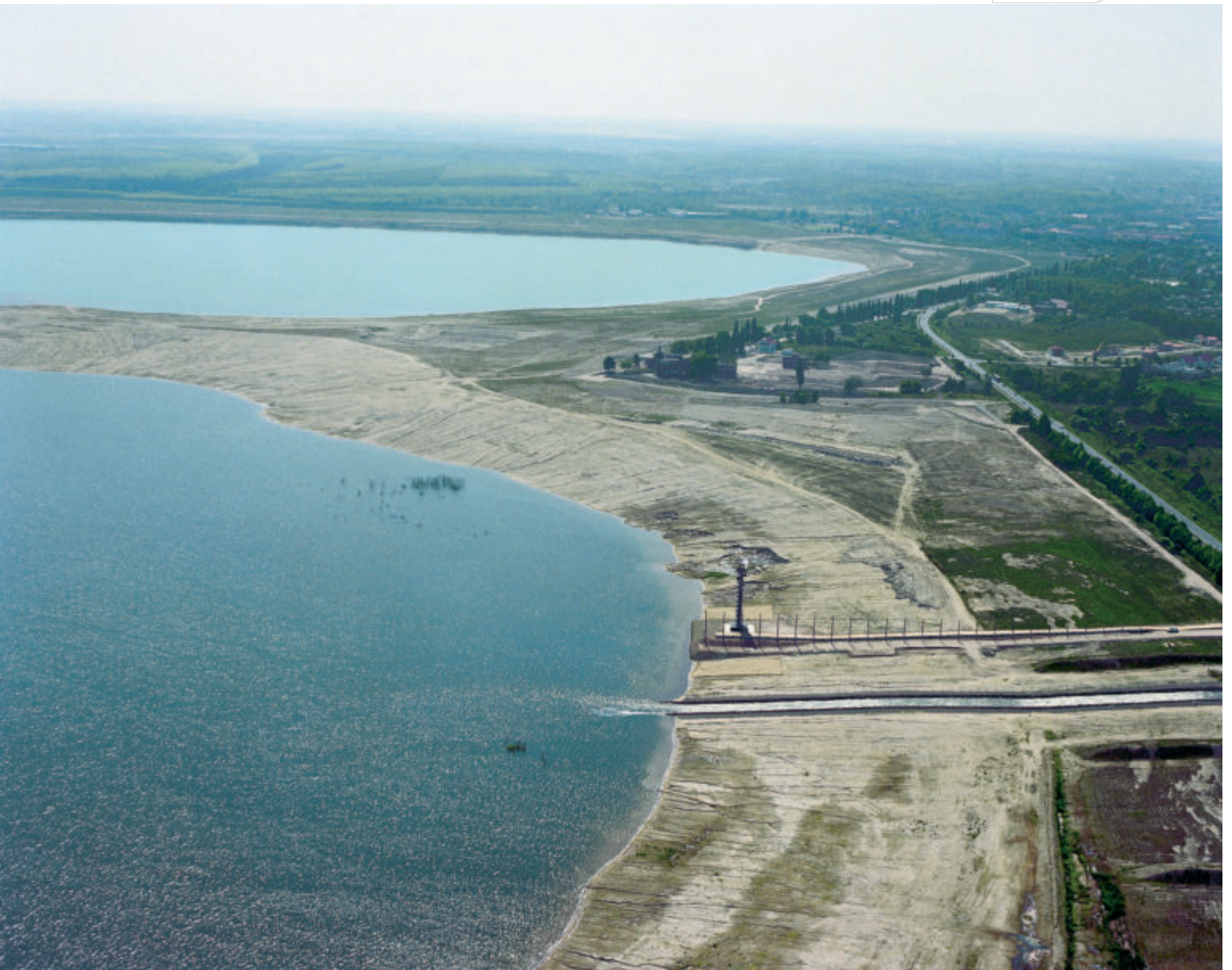
Die Konstruktions-Arbeiten für den Pegelturm begannen bereits 1997
