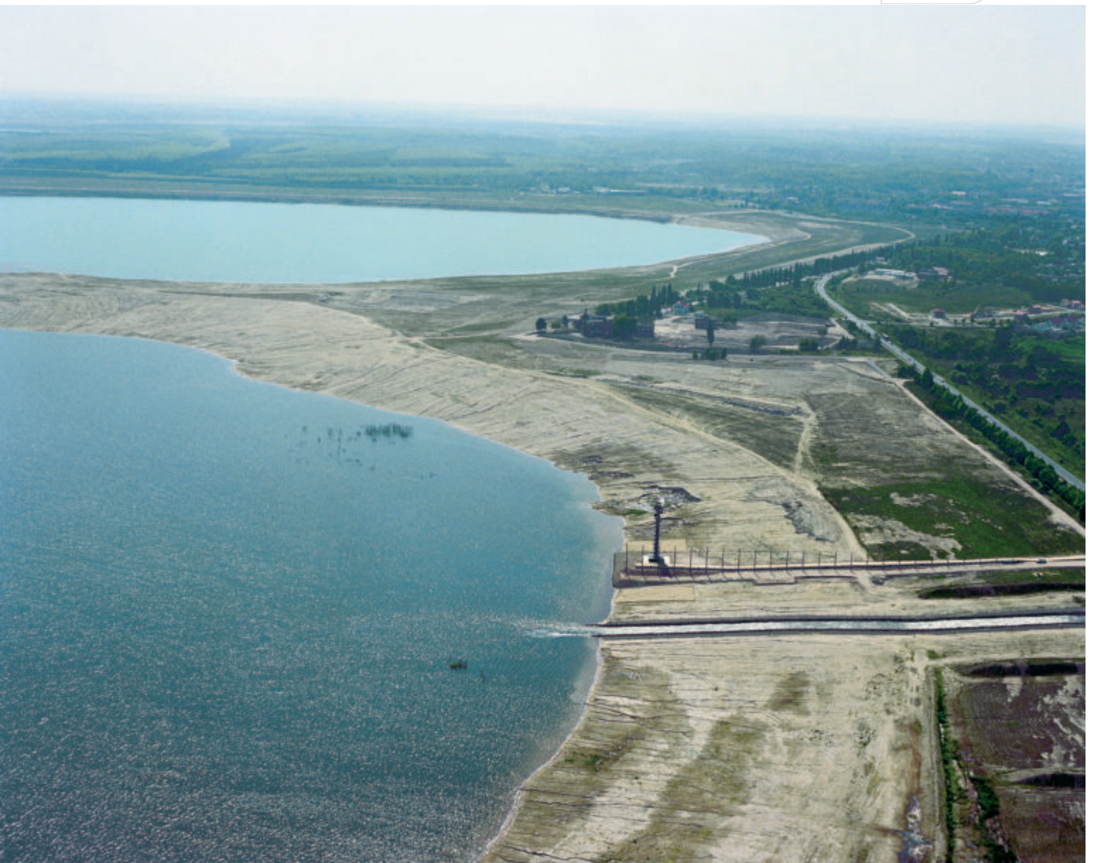
Die Konstruktions-Arbeiten für den Pegelturm begannen bereits 1997
