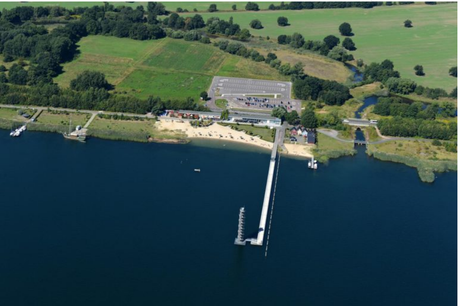
Goitzschesees: Blick auf den Pegelturm mit gestaltetem Strandbereich
