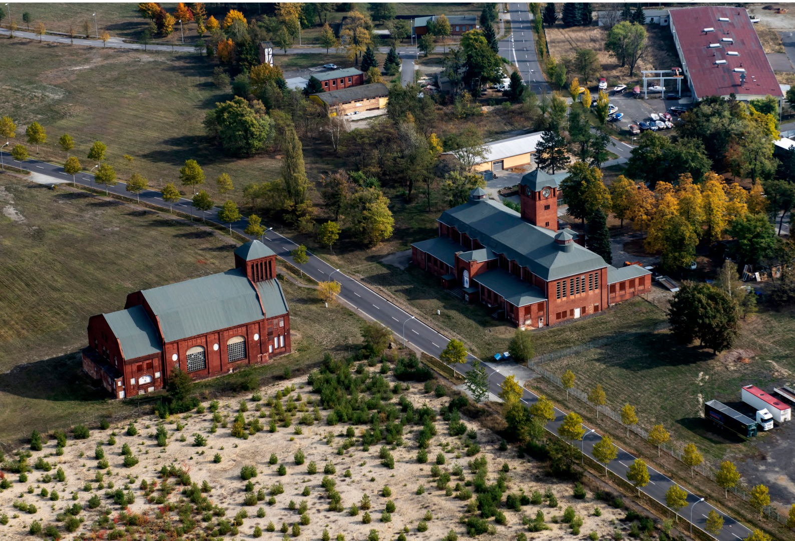
Denkmalgeschütztes Gebäudeensemble des Zechenhauses und der Kraftzentrale
