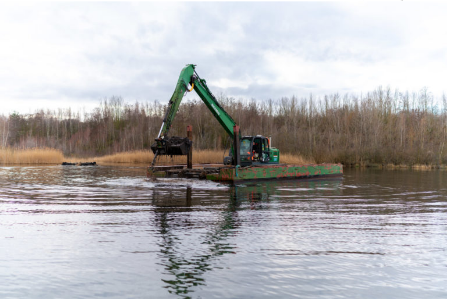
Der Filterbrunnen wird freigelegt und anschließend fachgerecht verwahrt.
