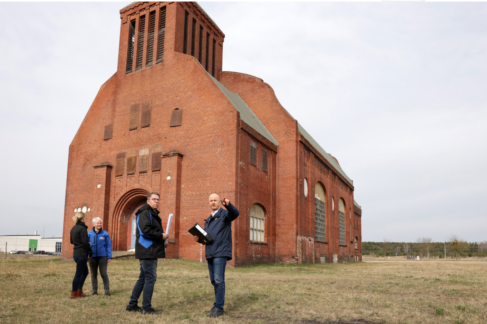
LMBV Kraftzentrale Marga
