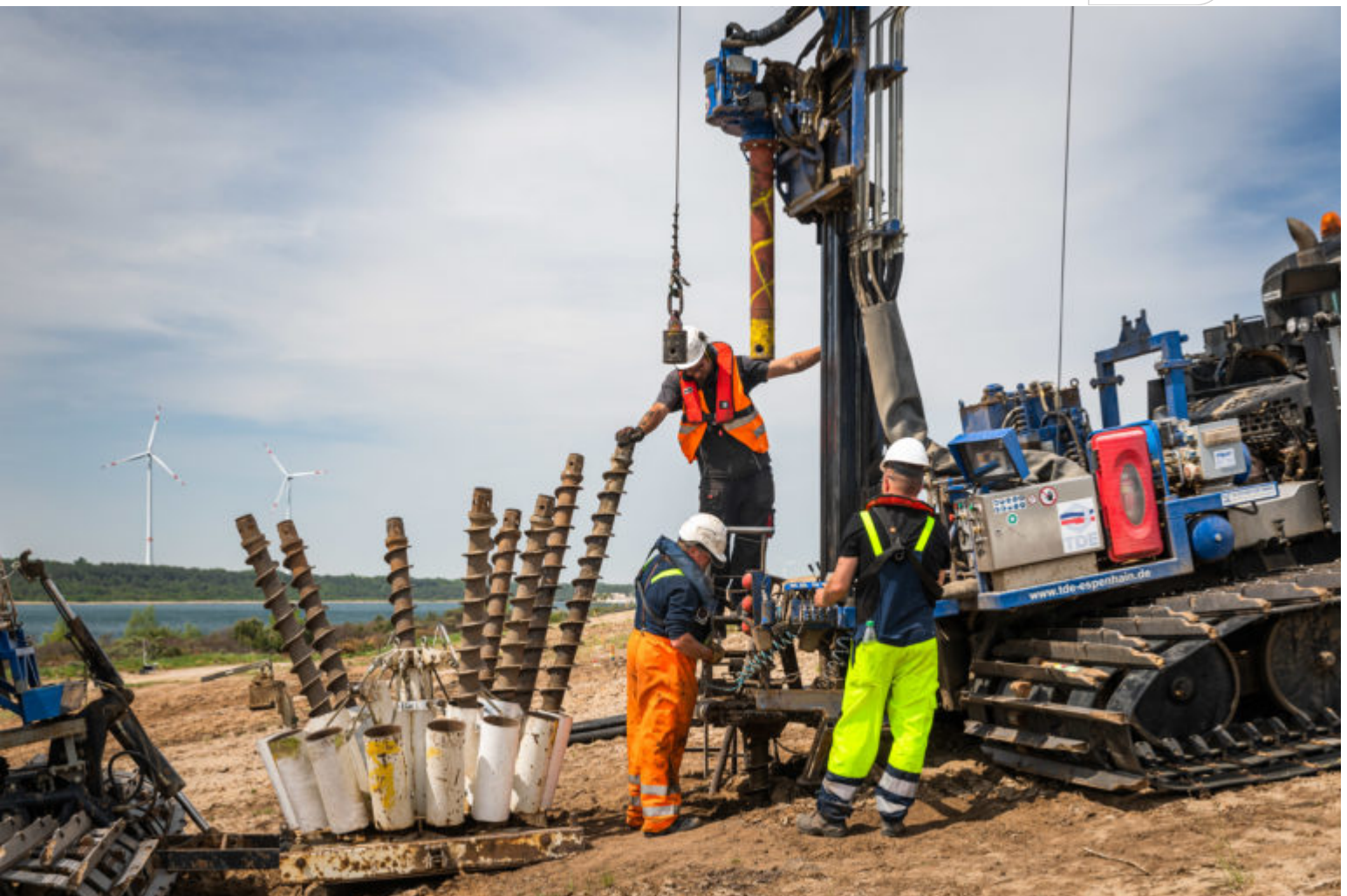
Beispiel für Schonende Sprengverdichtung
