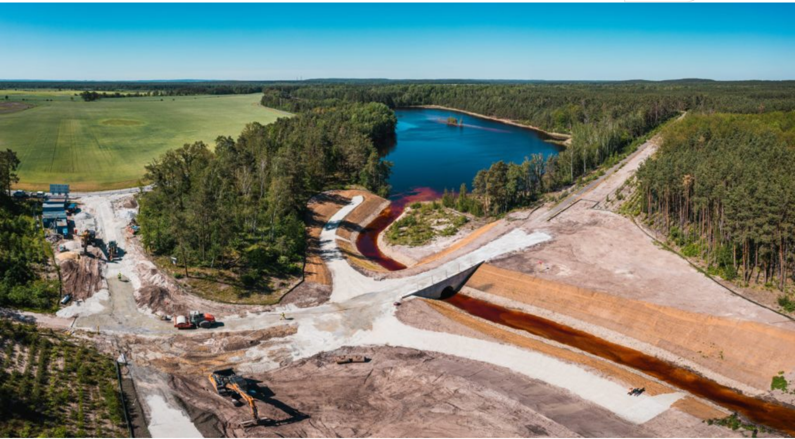
Fast fertiggestellter Durchlass zwischen RL 76 und 78 in 2024
