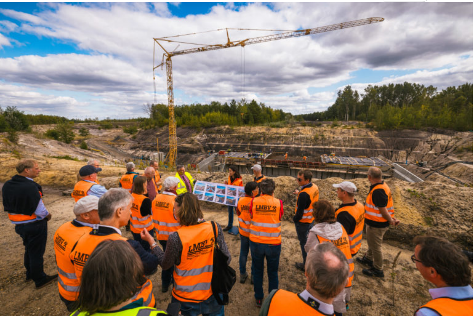
M. Matthes und V. Wolf informieren am Brückenbauwerk der L60 Fotos: Gernot Menzel
