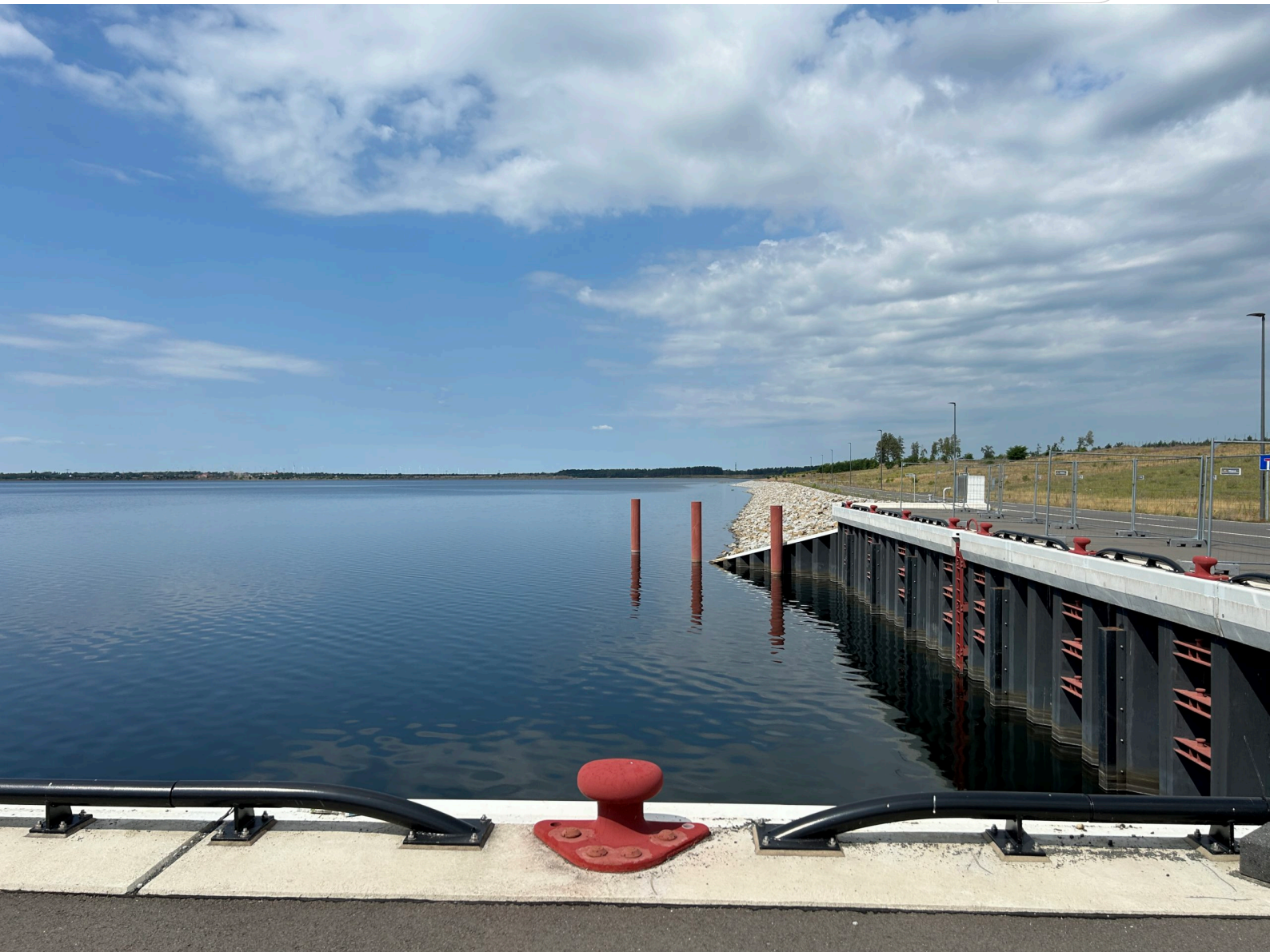
Sanierte Uferböschung am Sedlitzer See
