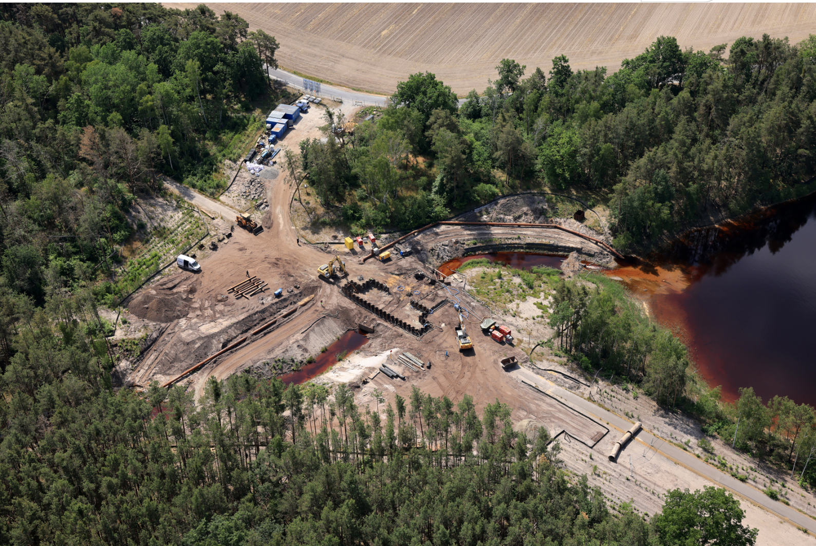
Baustelle für den Durchlass zwischen RL 76 und 78 in 2023
