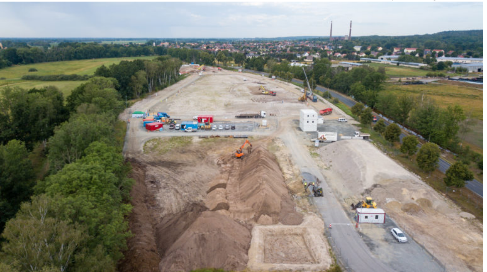
Die Baustelle der künftigen Wasserbehandlungsanlage Plessa (Foto: Filmart Potsdam)
