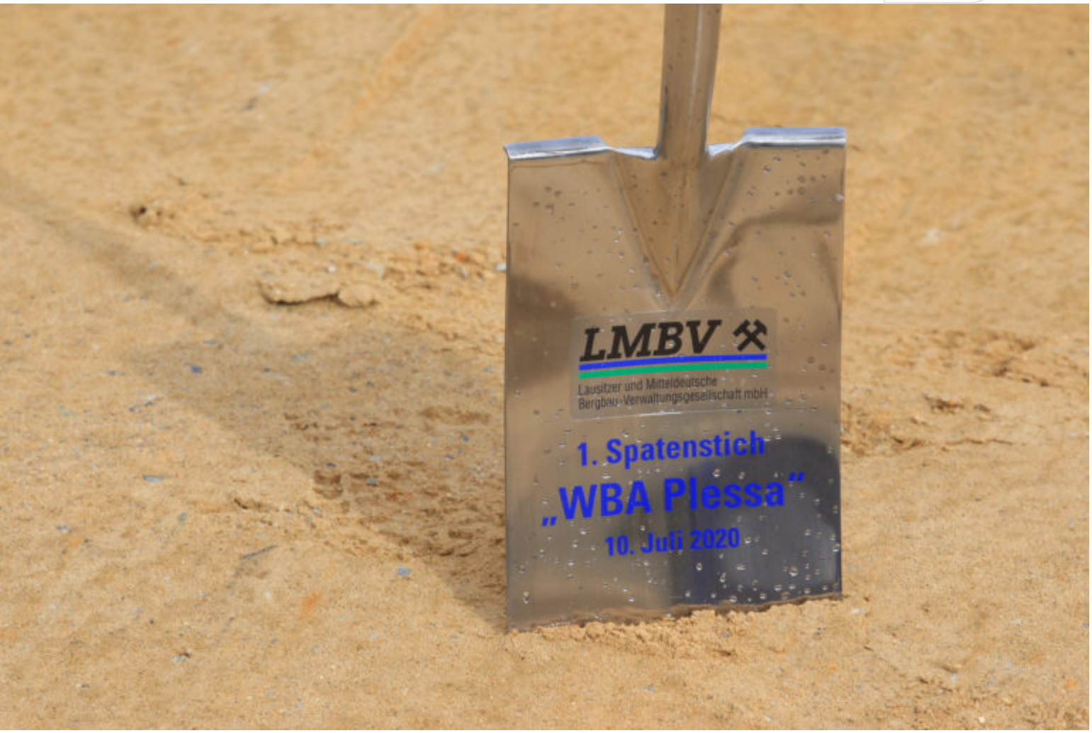
Erster Spatenstich für die Wasserbehandlungsanlage Plessa
