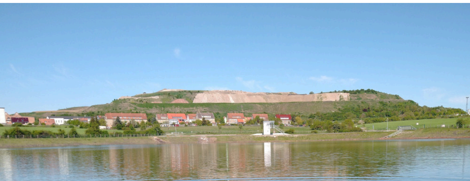
Blick über das Stapelbecken auf die LMBV-Halde Menteroda Impressionen vom Leitungsbau
