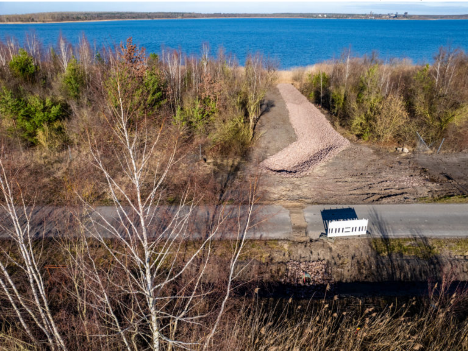
Einer der neuen Ableiter, über den das Wasser aus den Entwässerungsgräben in den Gremminer See fließen wird.
