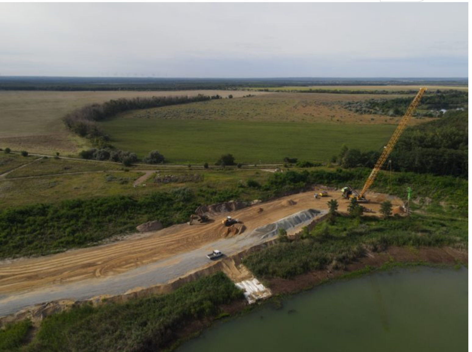
Sichtbarer Verdichtungsfortschritt auf der Rütteltrasse am RL A
