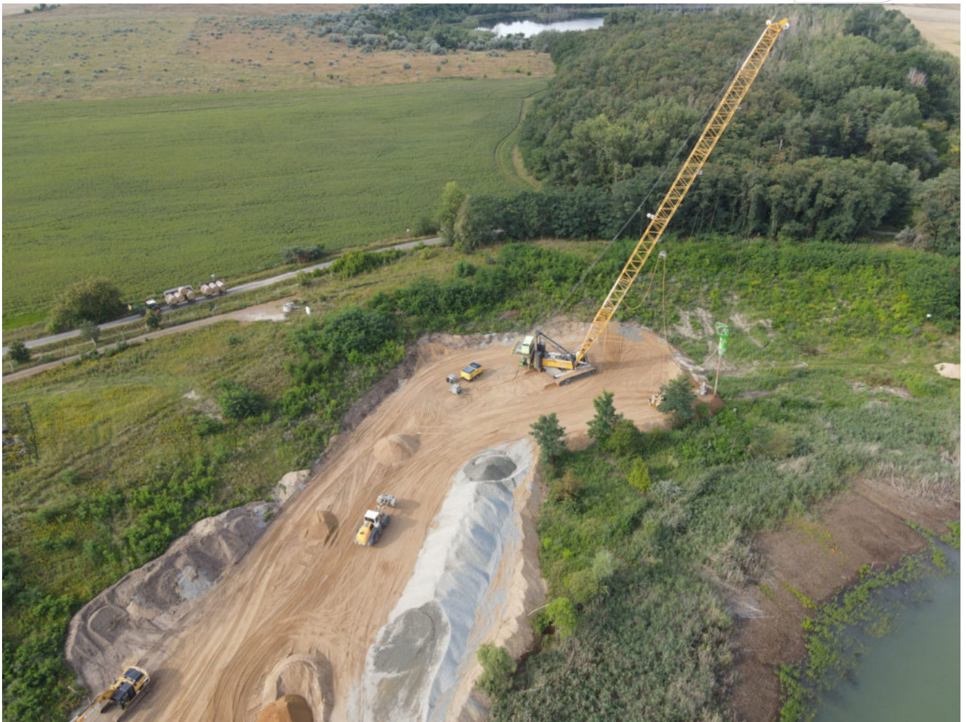
Blick über die Arbeiten am Restloch A
