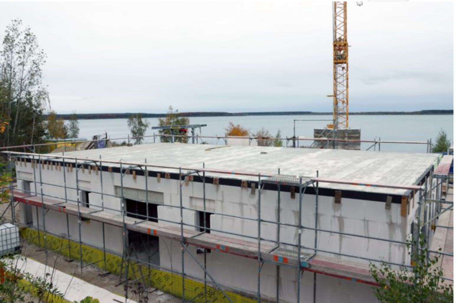
Der Rohbau des neuen Multifunktionsgebäudes
