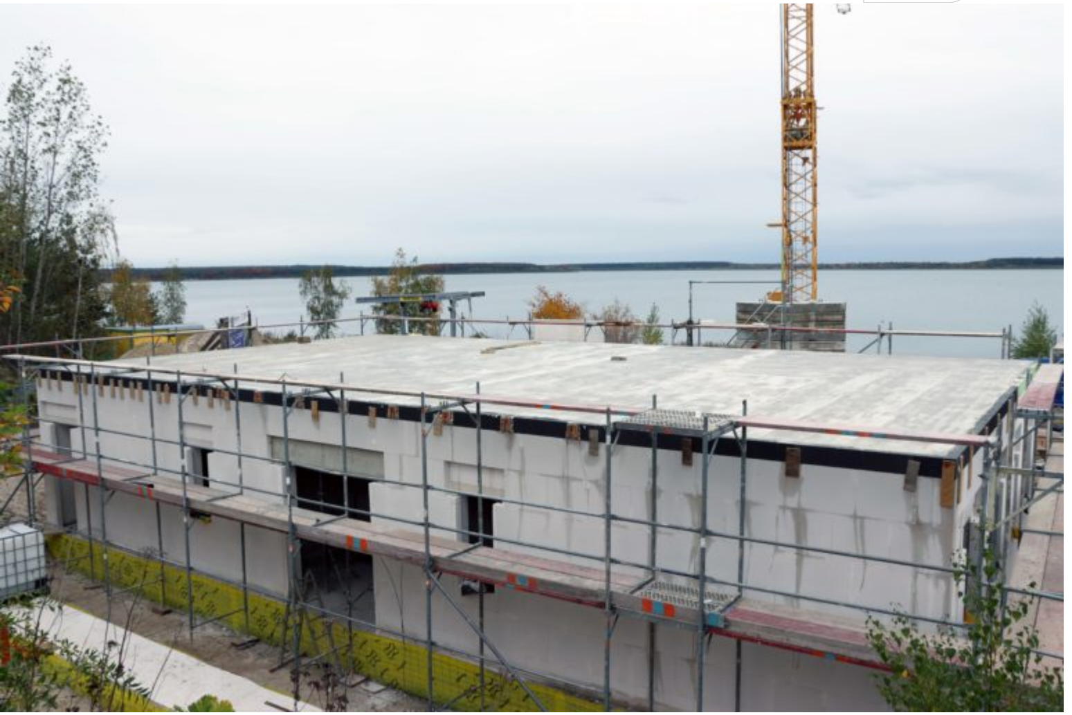
Der Rohbau des neuen Multifunktionsgebäudes
