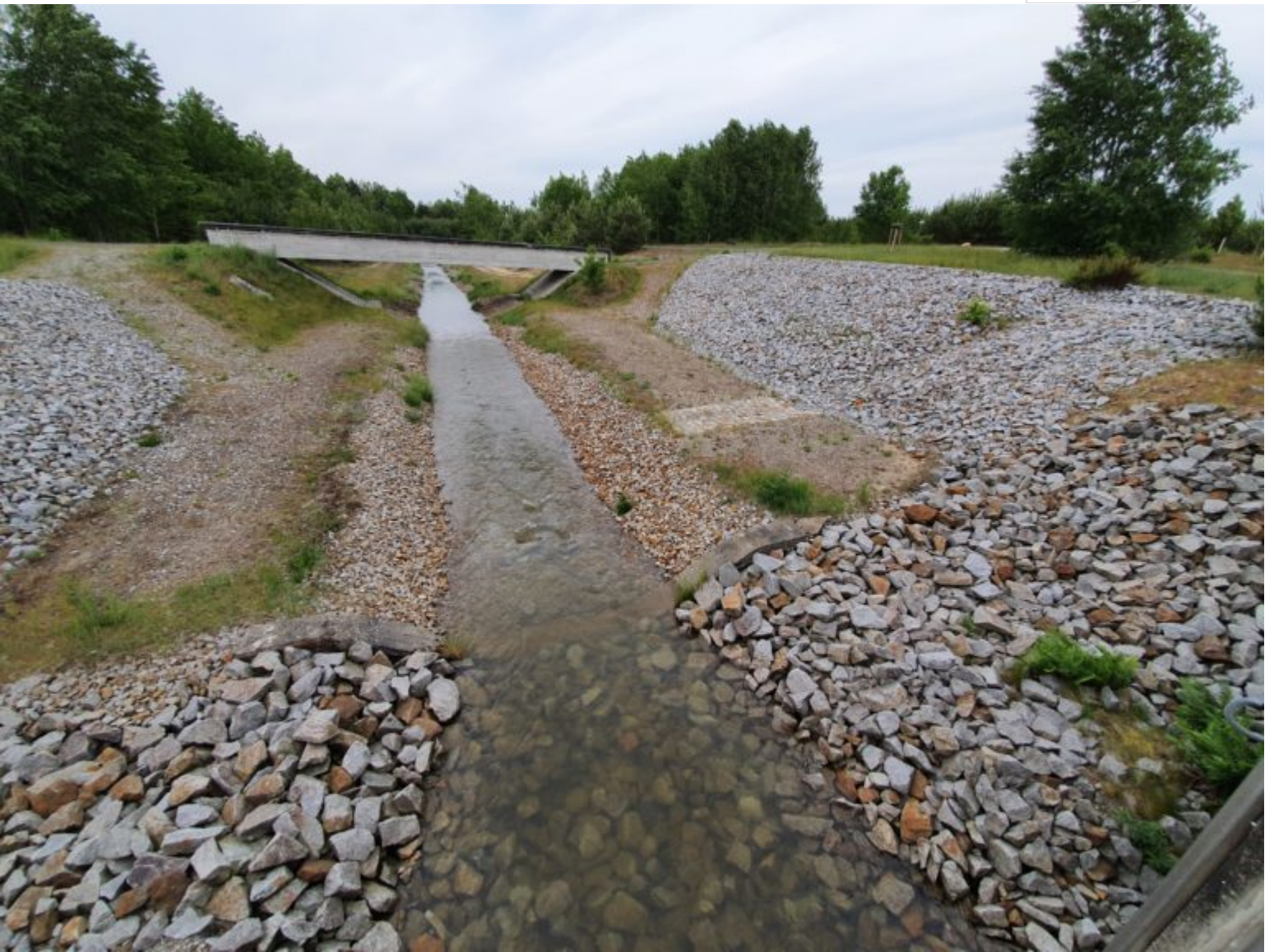
Ableiter aus dem Bergbaufolgesee und Speicher Bärwalde
