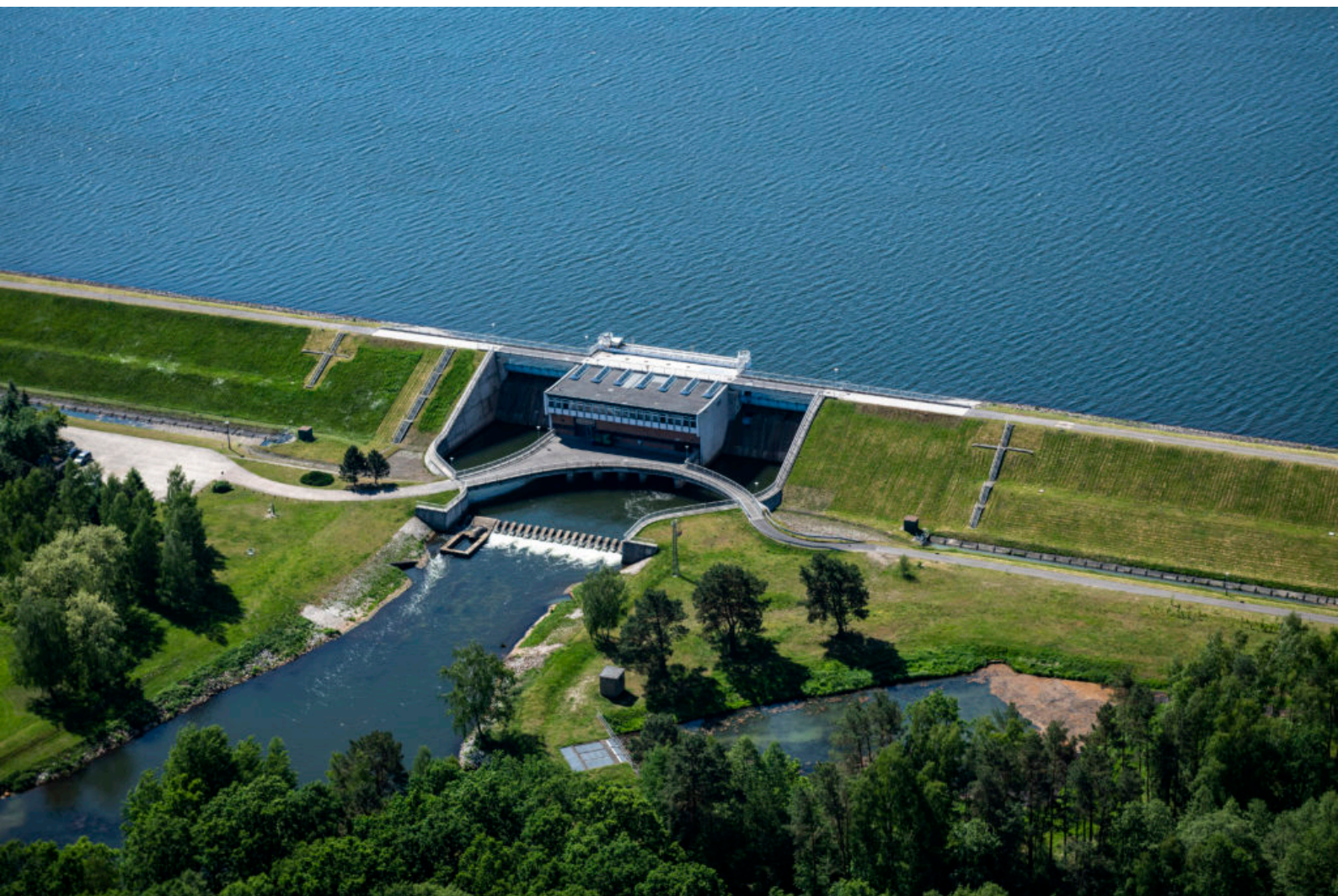
Talsperre Spremberg - Archivfoto Staumauer Potsdam/Cottbus. Die länderübergreifende „Ad-hoc-AG Extremsituation“
