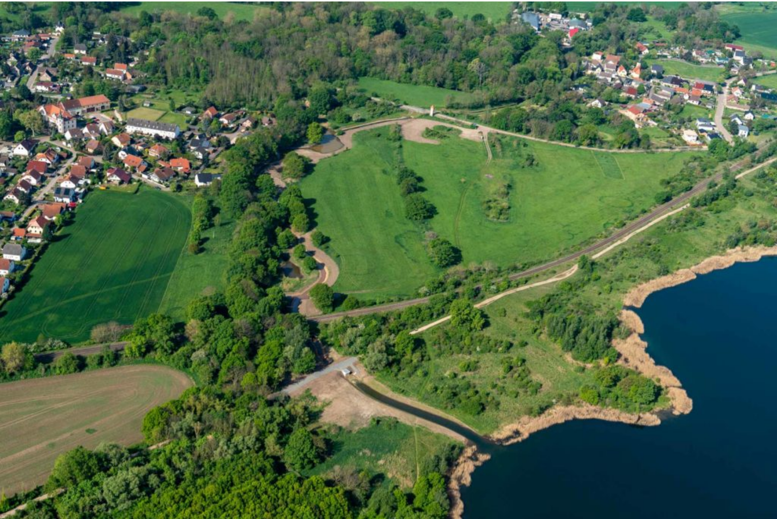
Luftaufnahme des Ableiters Merseburg-Ost in seinem ganzen Verlauf, kurz nach Fertigstellung.
