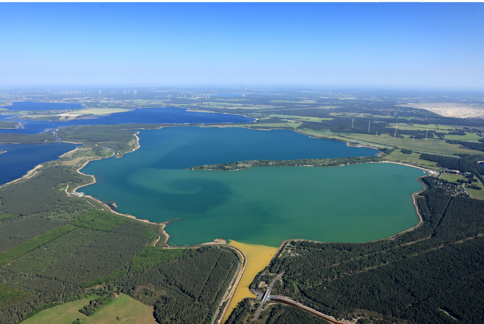
Blick über die Restlochkette – aus Osten nach Westen
