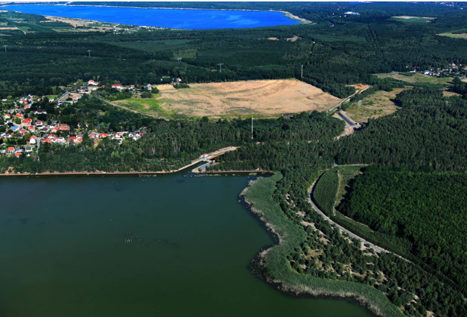
Auslaufbauwerk aus dem Speicher Burghammer zur Kleinen Spree
