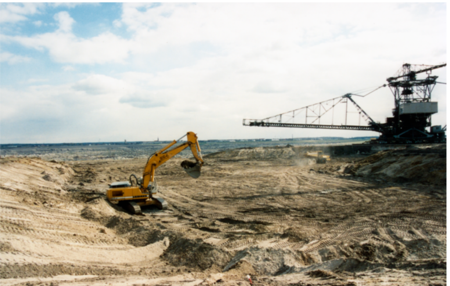
Bau der Ferropolis-Arena 1999
