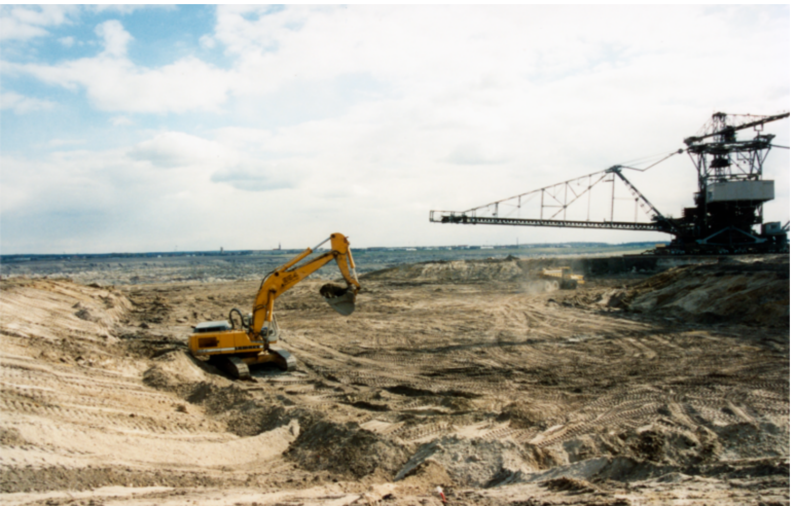
Bau der Ferropolis-Arena 1999
