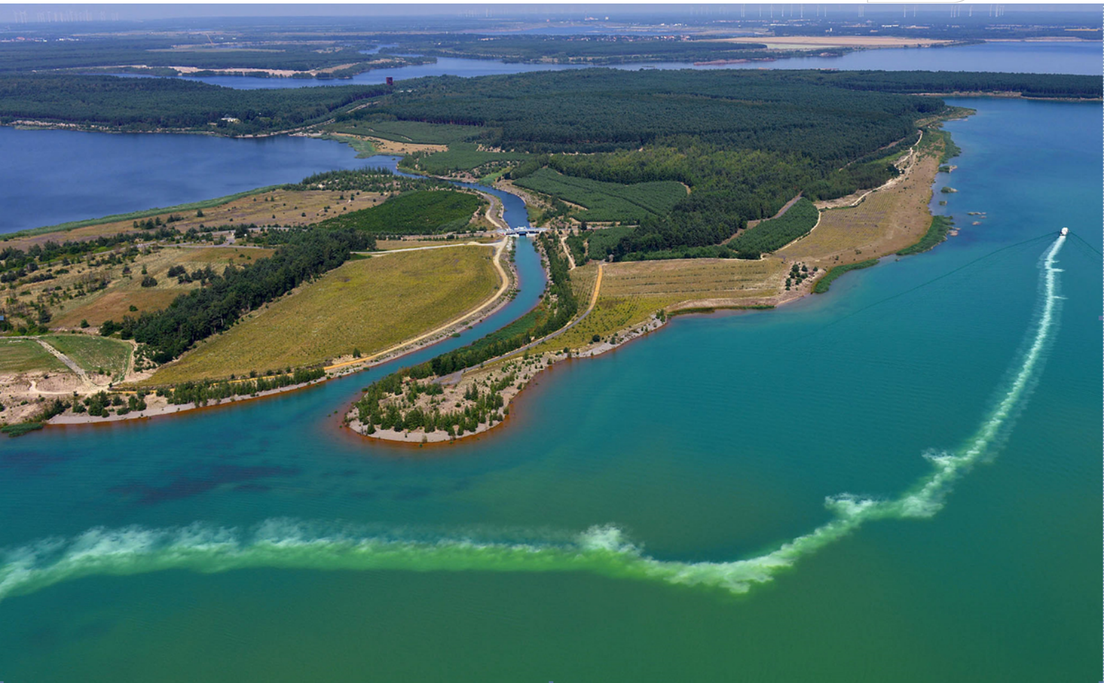
Einsatz von Kalkprodukten mit Sanierungsschiff
