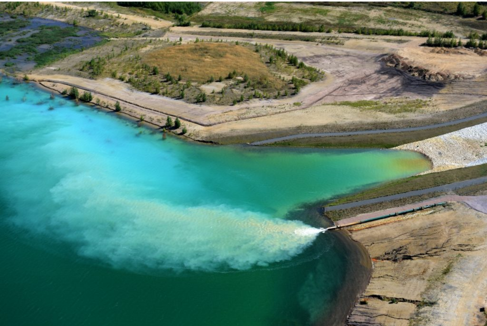
LMBV-Bergbaufolgesee: Einleiten von Kalkmilch zur Konditionierung
