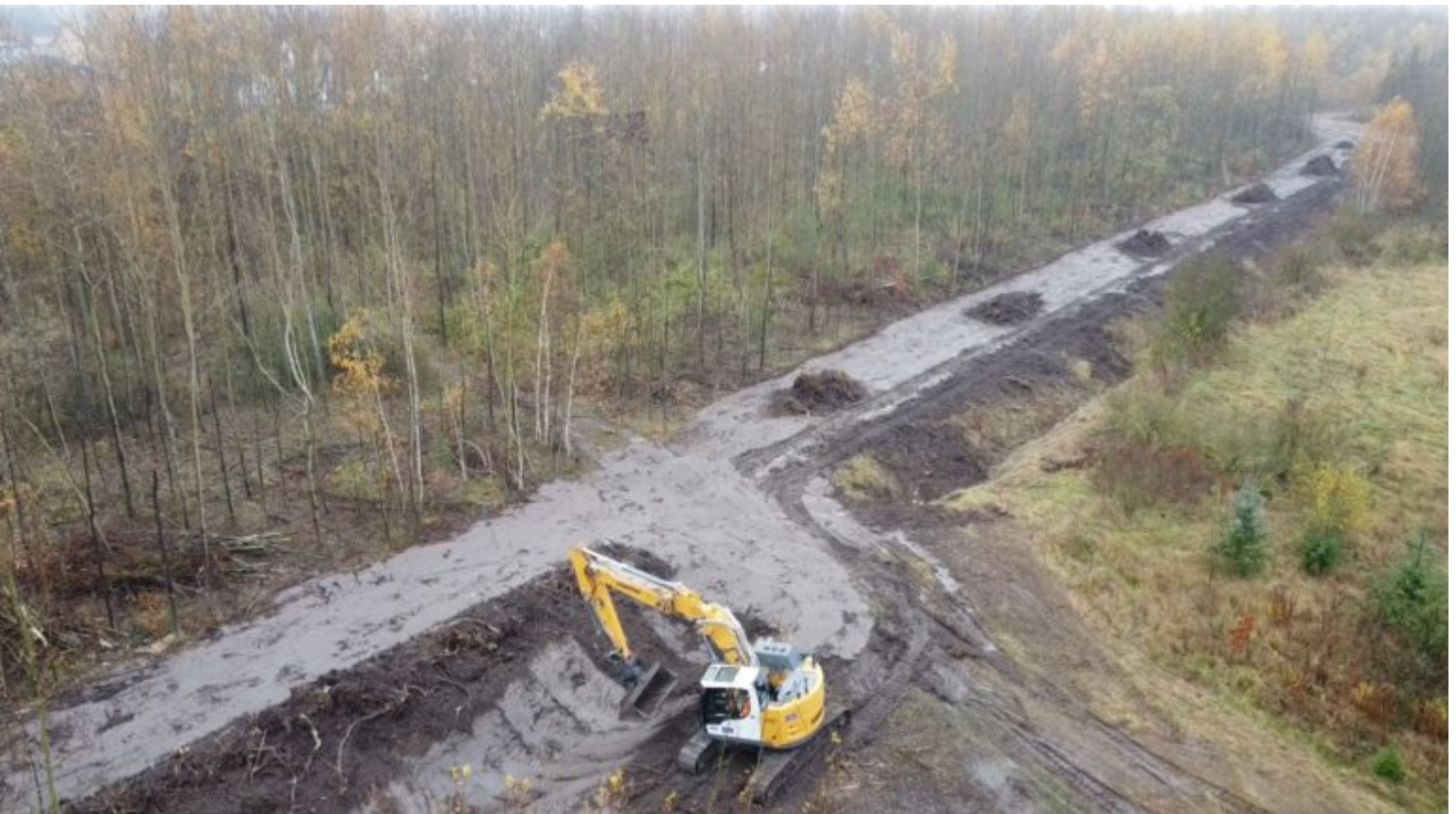
Beginn der Bauarbeiten
