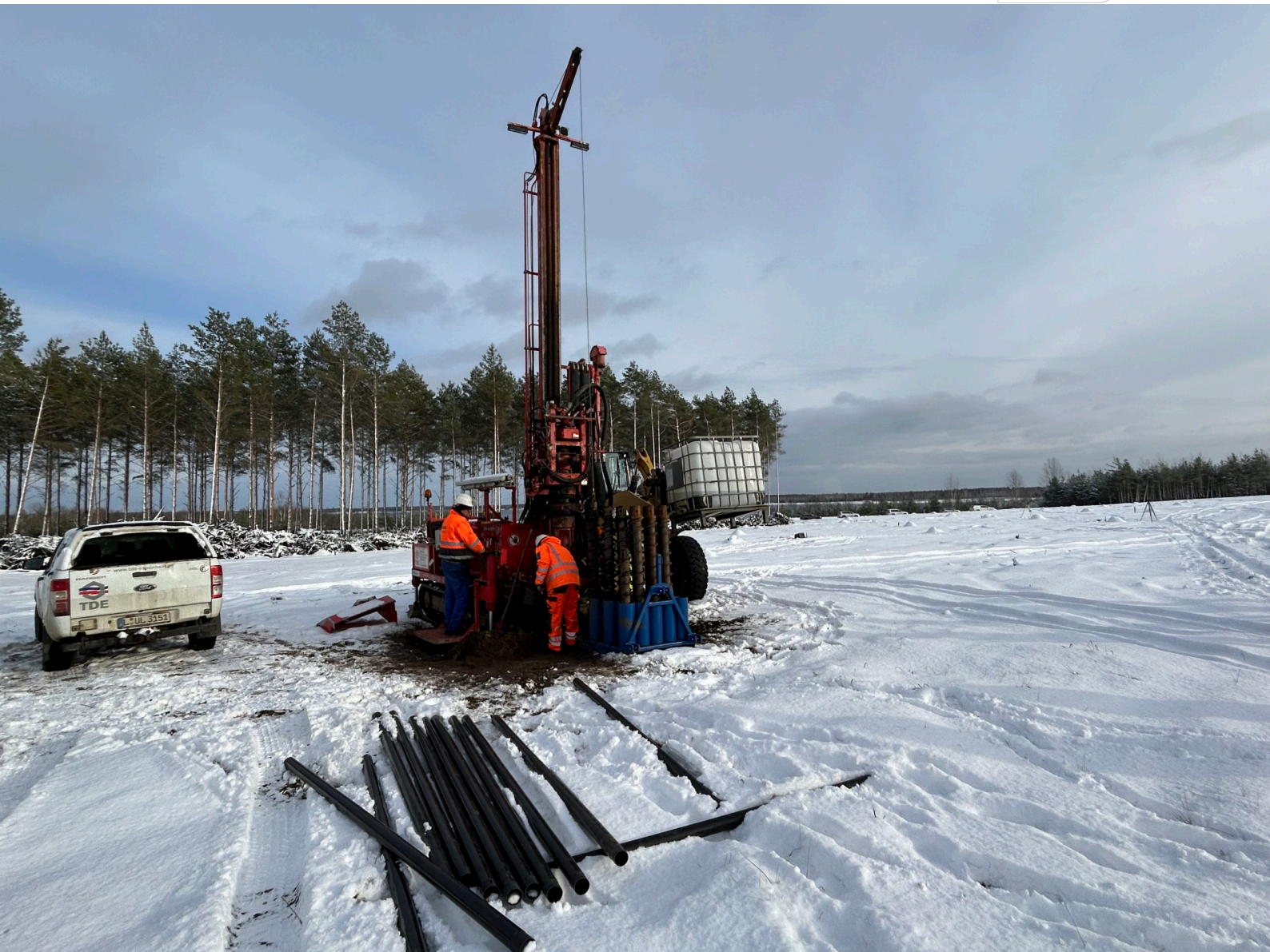
Abteufen der Bohrlocher für das Sprengen auf der Brückenfeldkippe
