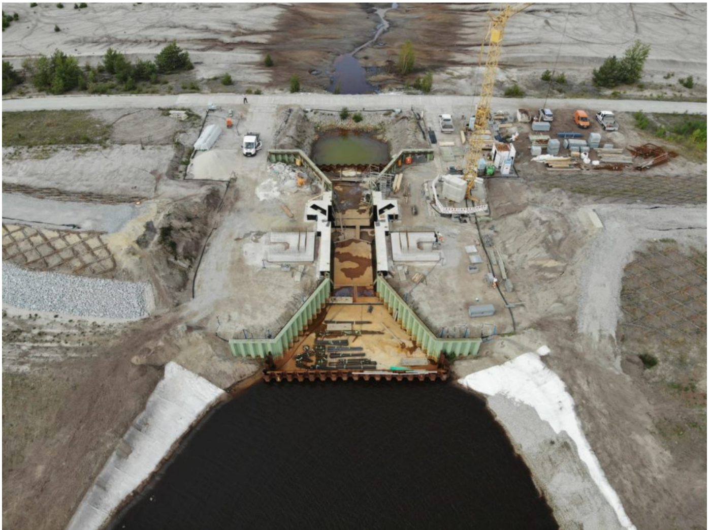
Impressionen vom Bauvorhaben Überleiter 3 a
