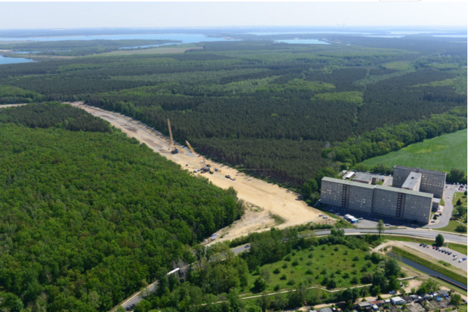
LMBV: Ableiter vom Sedlitzer See im Bau
