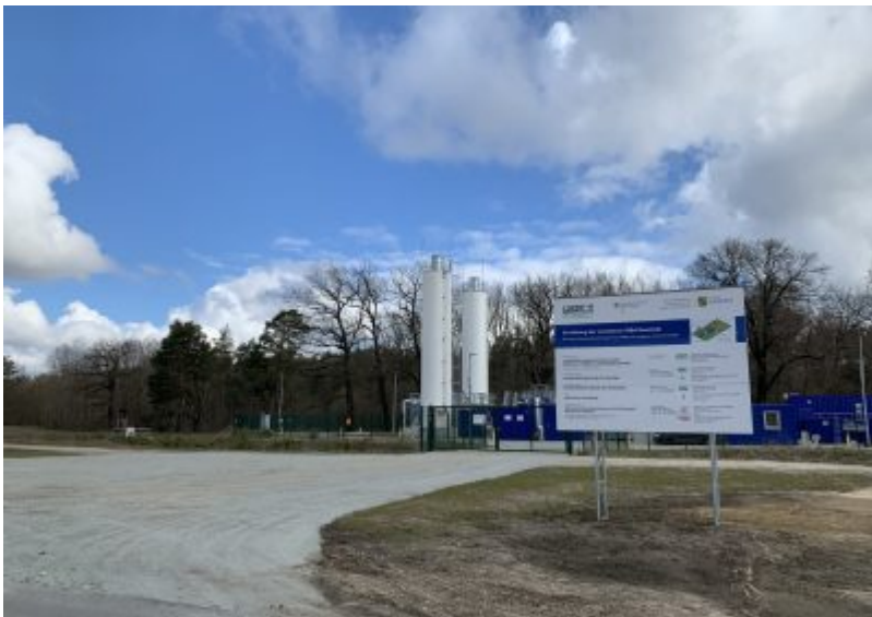
LMBV-Anlage bei Neustadt an der Spree
