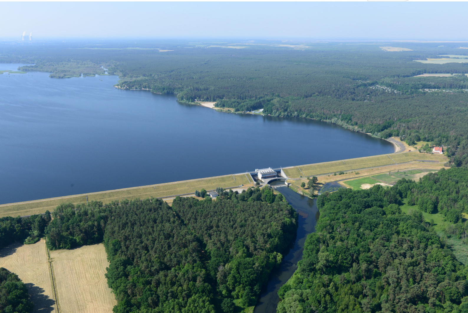
Talsperre Spremberg: Staumauer mit Auslauf
