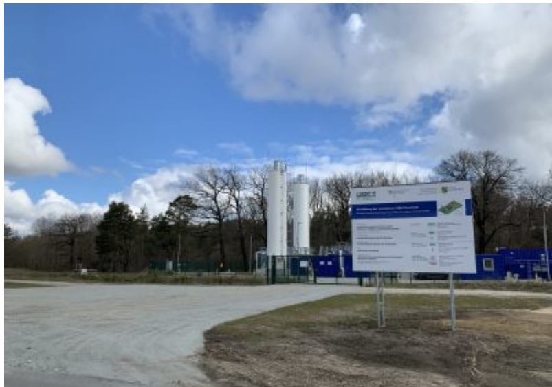
LMBV-Anlage bei Neustadt an der Spree
