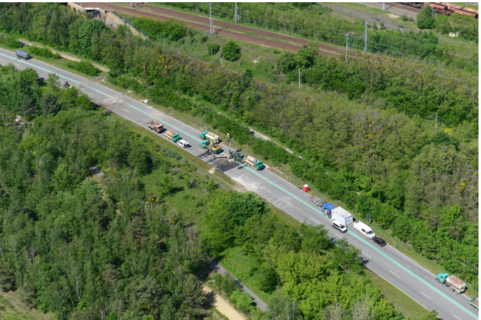
LMBV Luftaufnahme vom Streckenverwahren an B 169 vom 03.06.21 Steffen Rasche
