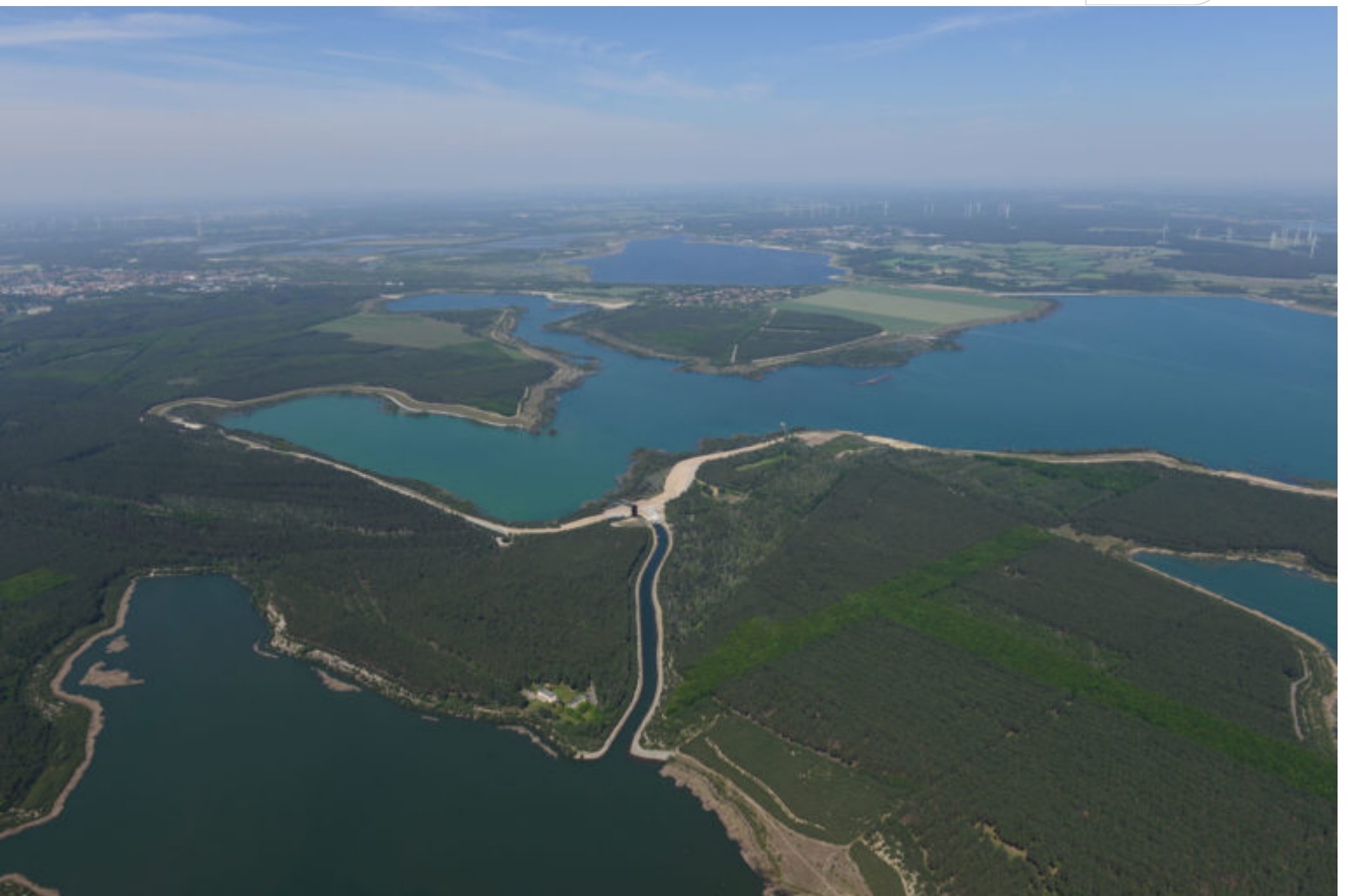
LMBV-Bergbaufolgeseeen: Sornoer Kanal zw. Sedlitzer See und Geierswalder See
