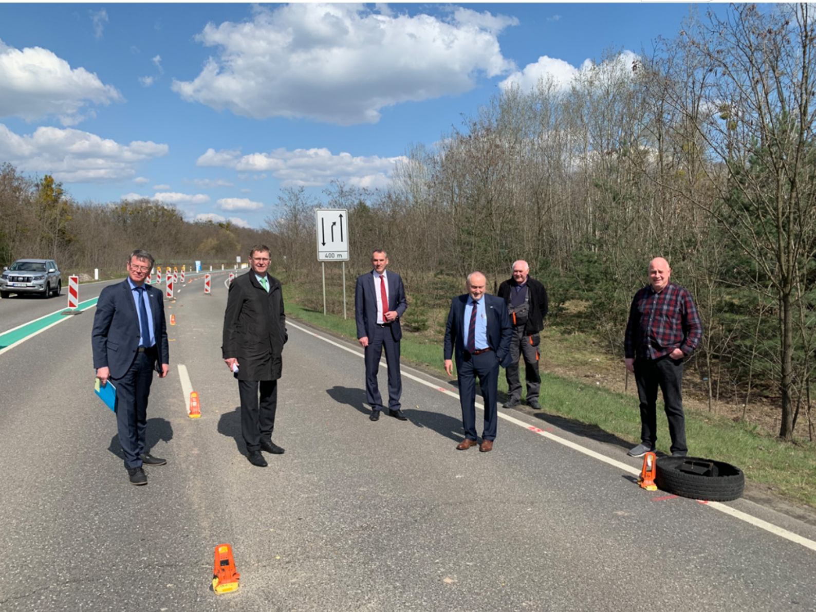
Alle Involvierten sind sich der Erschwernisse durch das Sperren bewusst. Gespernte B 169 nach Gefahrerkennung
