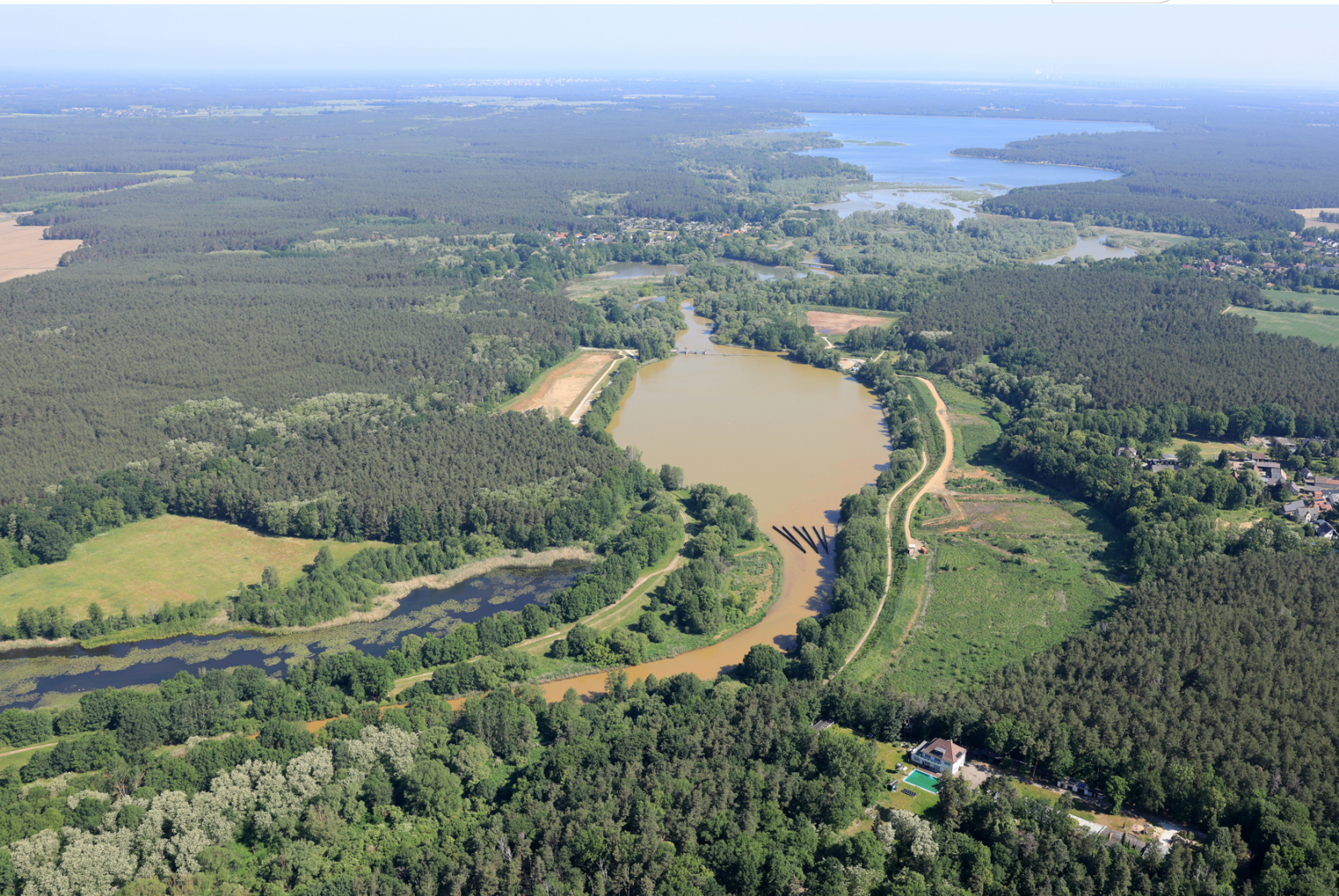
Blick auf die Vorsperre Bühlow; im Hintergrund die Talsperre Spremberg
