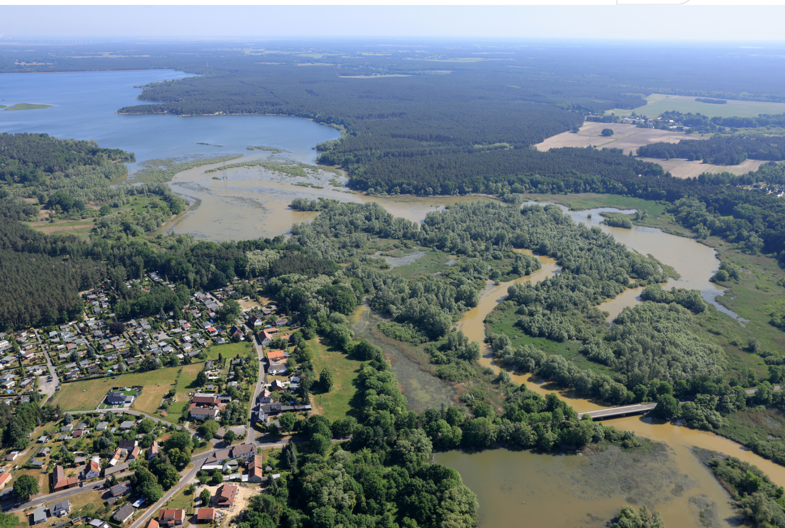
Einlauf der Talsperre Spremberg
