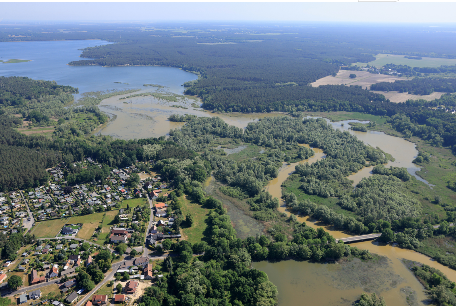
Einlauf der Talsperre Spremberg
