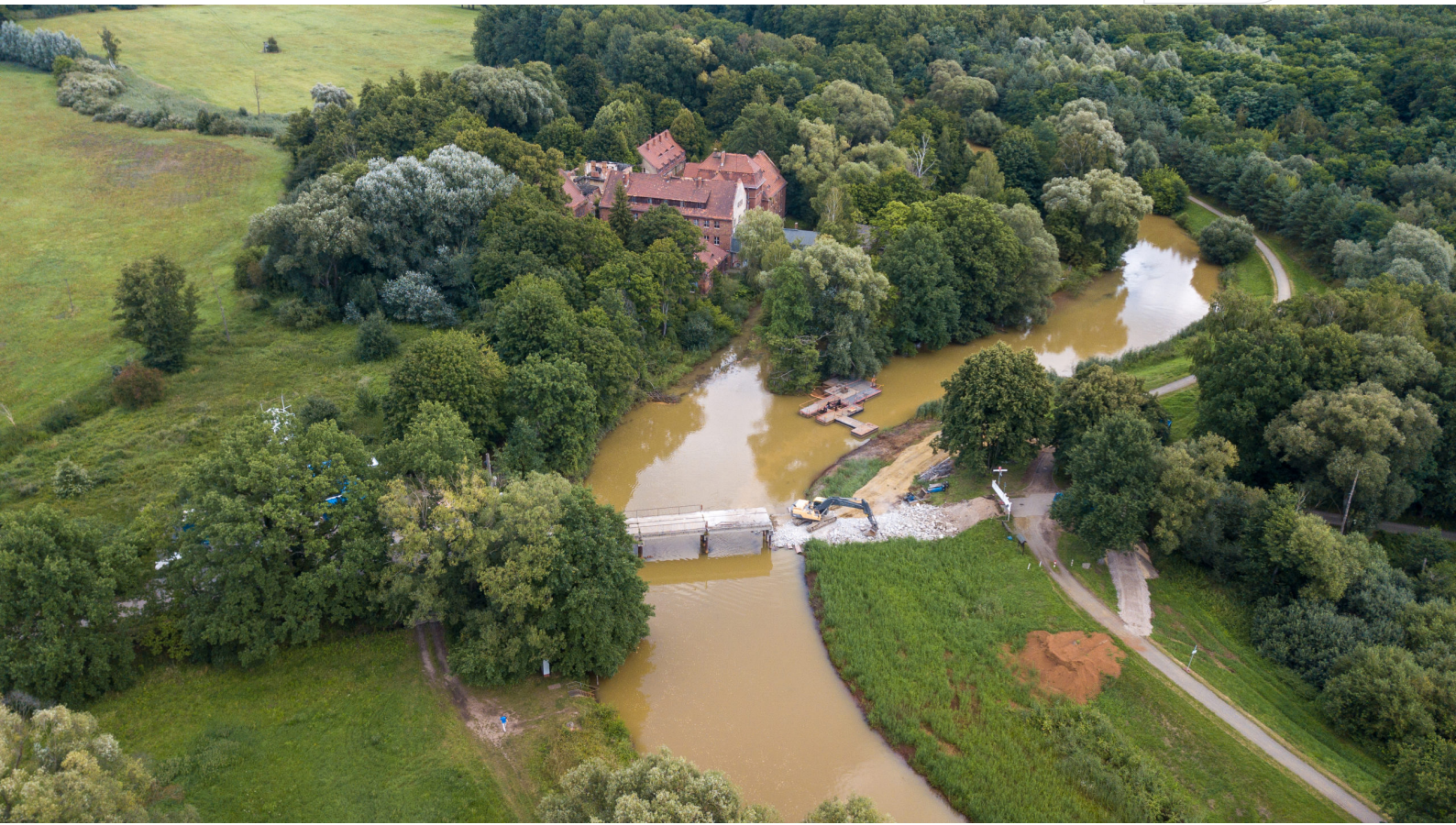
Ersatzneubau der Austragsleitung an der Konditionierungsanlage Wilhelmsthal
