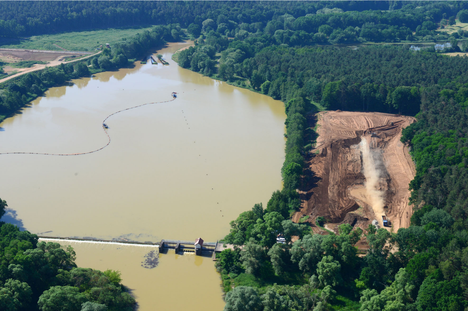
Sedimentationsbecken an der Vorsperre Bühlow
