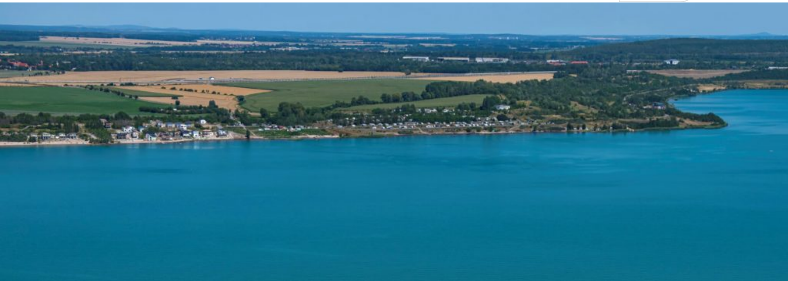
Zu sanierender nördlicher Uferbereich am Hainer See (Fotograf: Peter Radke)
