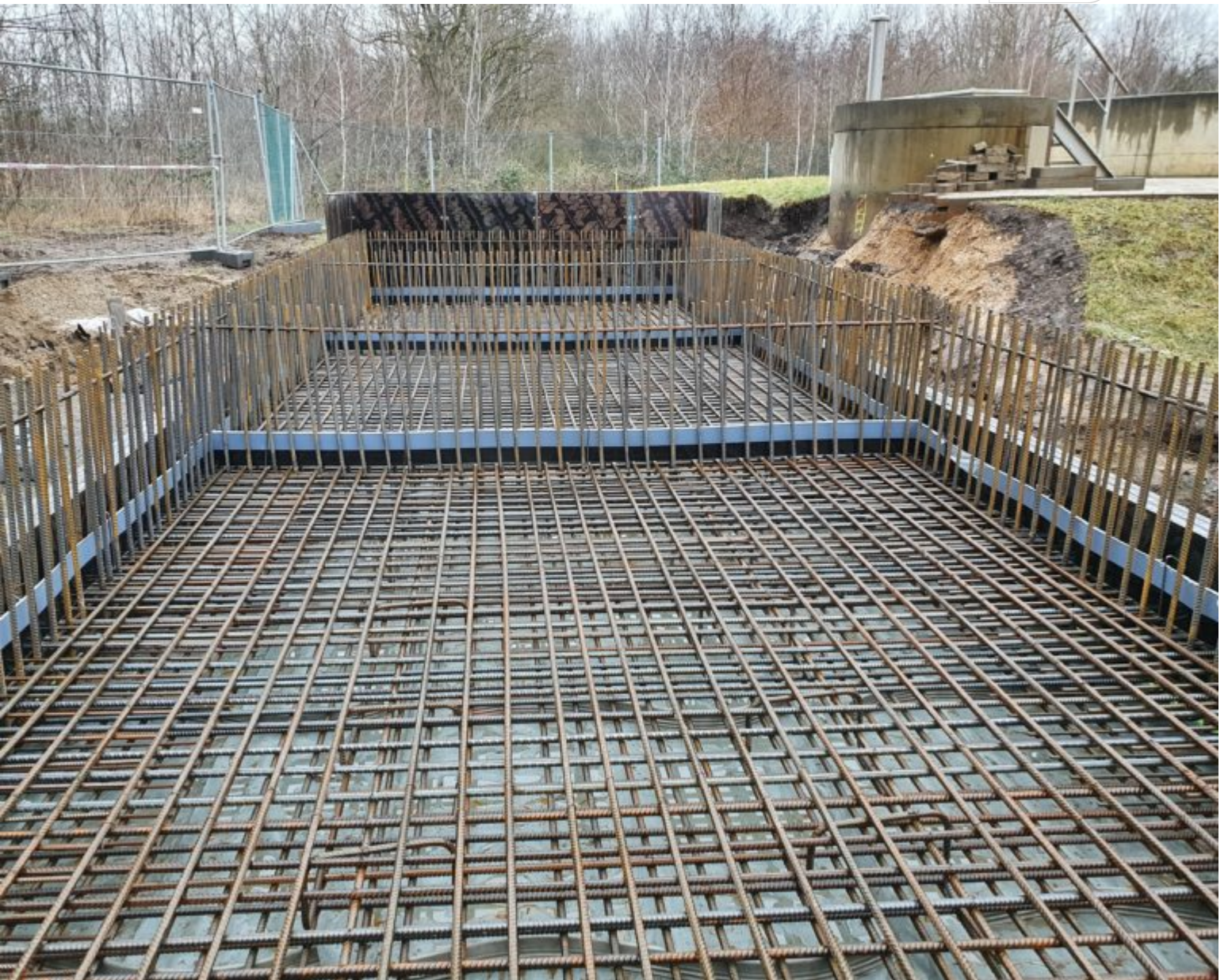
Bewehrung der Bodenplatte für das Drei-Kammer-Becken, das vor Ort gegossen wurde.
