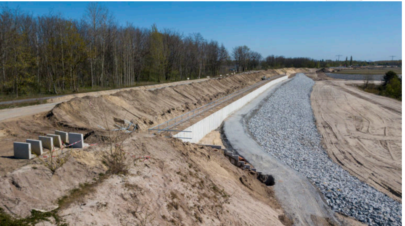
Erfolgter Uferverbau - Sedlitzer See
