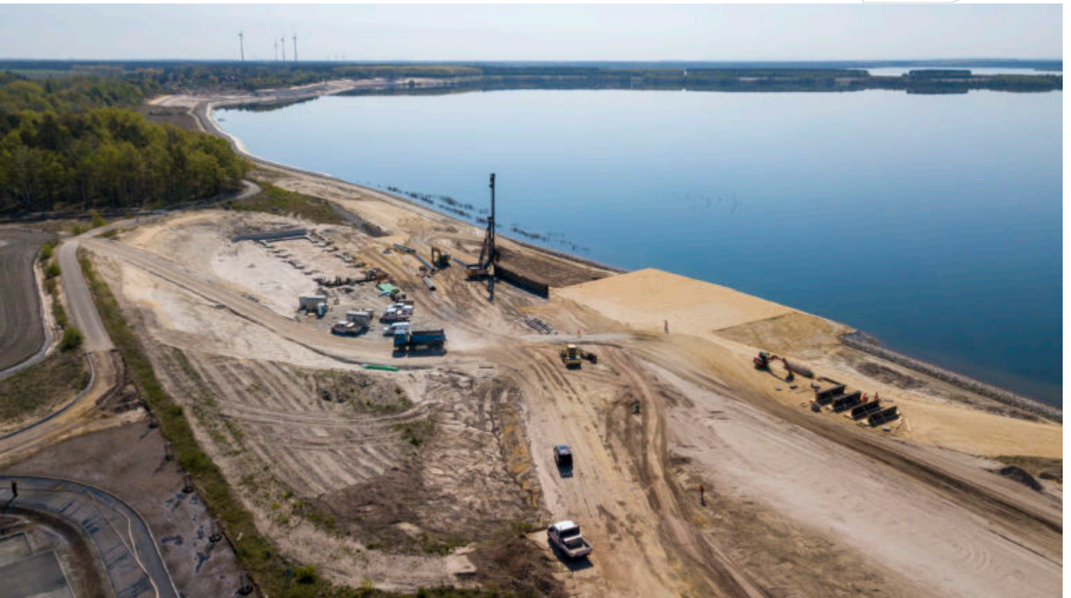
Blick über die entstehende Kaimauer im Norden des LMBV-Restloches Sedlitz
