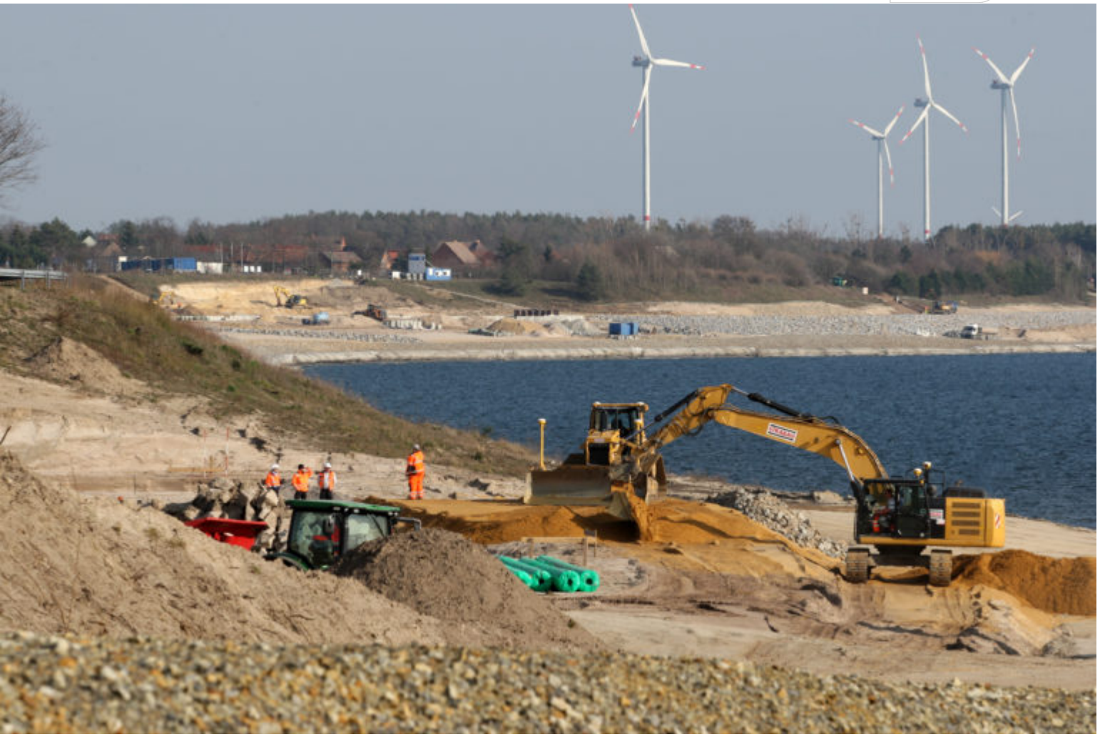
Sanierungsarbeiten: Investitionen für den Seestrand Lieske am künftigen Sedlitzer See
