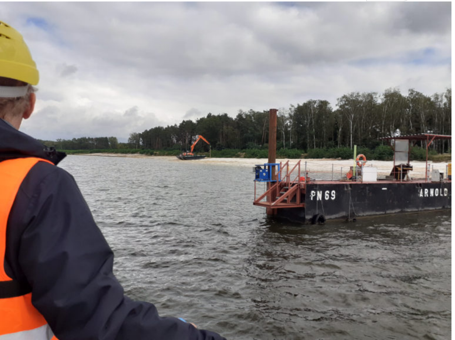
Verdichtungsarbeiten mit amphibischer Technik
