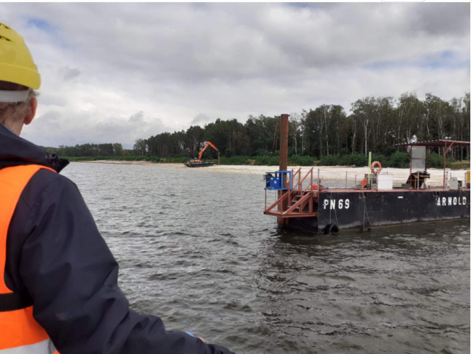
Verdichtungsarbeiten mit amphibischer Technik
