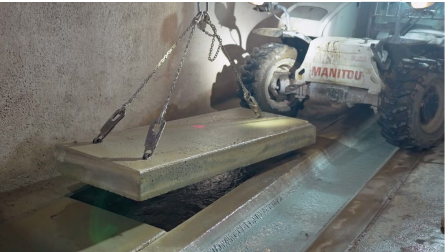
Anheben der Betonplatten
