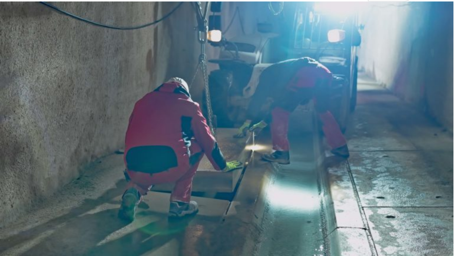
Einsetzen der Platten nach der Erneuerung
