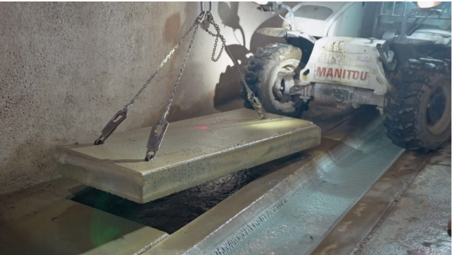
Anheben der Betonplatten
